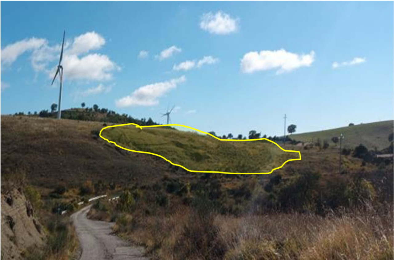
Fig 2 Corpo di frana: AREA A RISCHIO R1 – Rischio moderato
