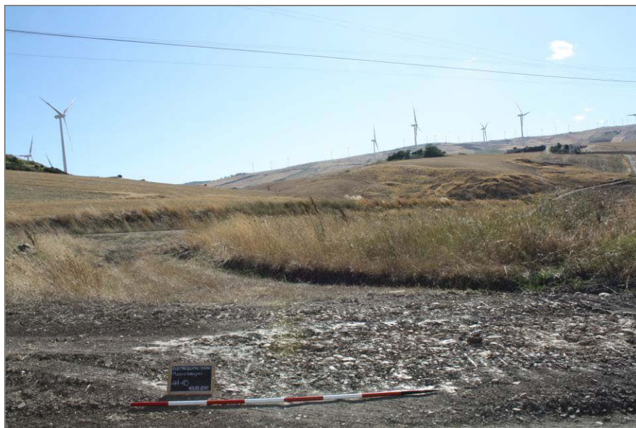
Fig. 50: Veduta generale del territorio attraversato dalla condotta elettrica all'altezza dei suoi Sostegni nn. 43 e 44 (sullo sfondo, a destra, Masseria Mirabella)
