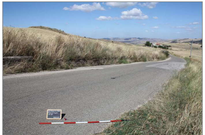
Fig. 43 (sopra): Veduta generale del tratto di condotta compresa tra i Sostegni nn. 35 e 36 (documentazione fotografica realizzata a ritroso, a partire all'incirca dalla zona destinata al Sostegno n. 36, più precisamente dalla Strada Provinciale n. 101)
