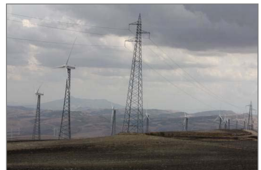
Fig. 62: Particolare delle infrastrutture presenti presso l'area del Sostegno n. 58, in località Piano delle Manarie
