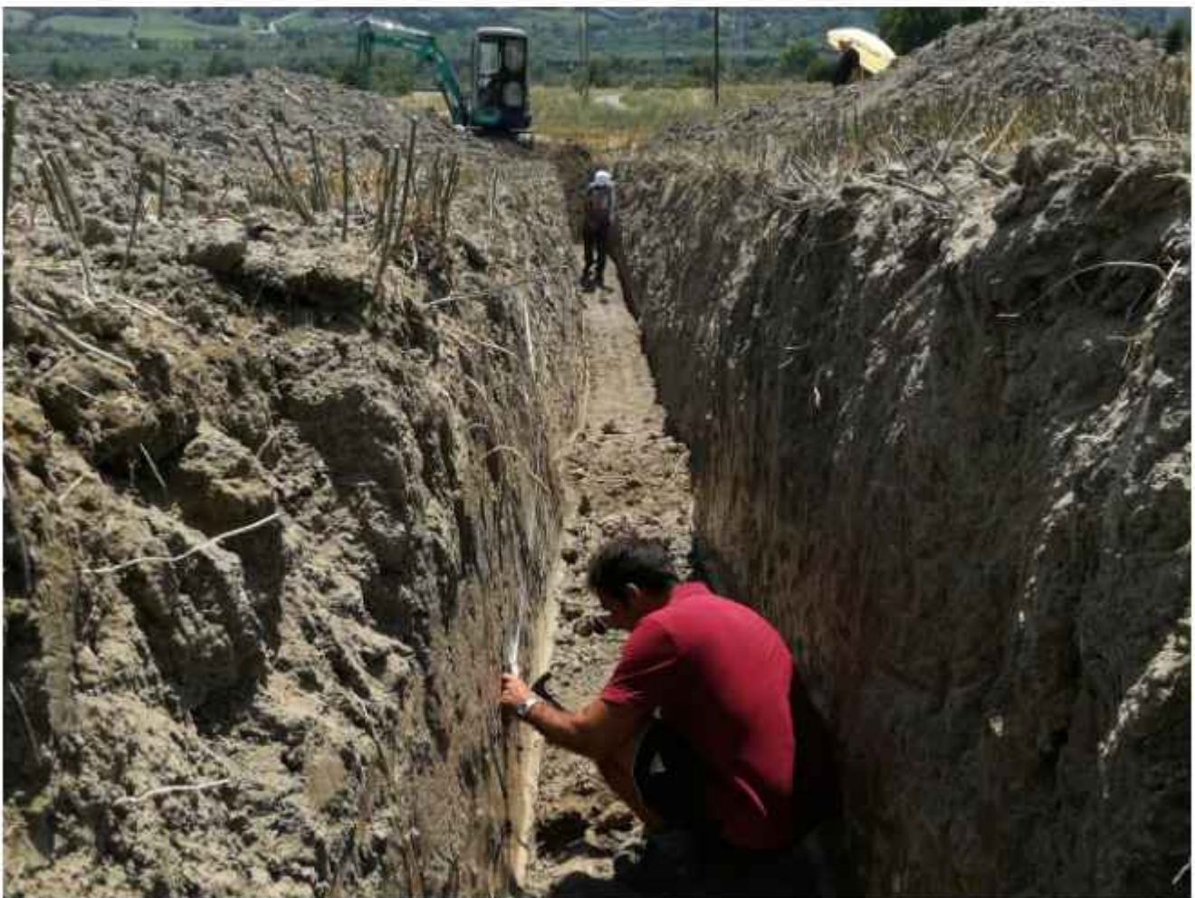
Figura 5.24 - Foto di dettaglio della caratterizzazione dello scavo esplorativo "Trincea Acinello".
