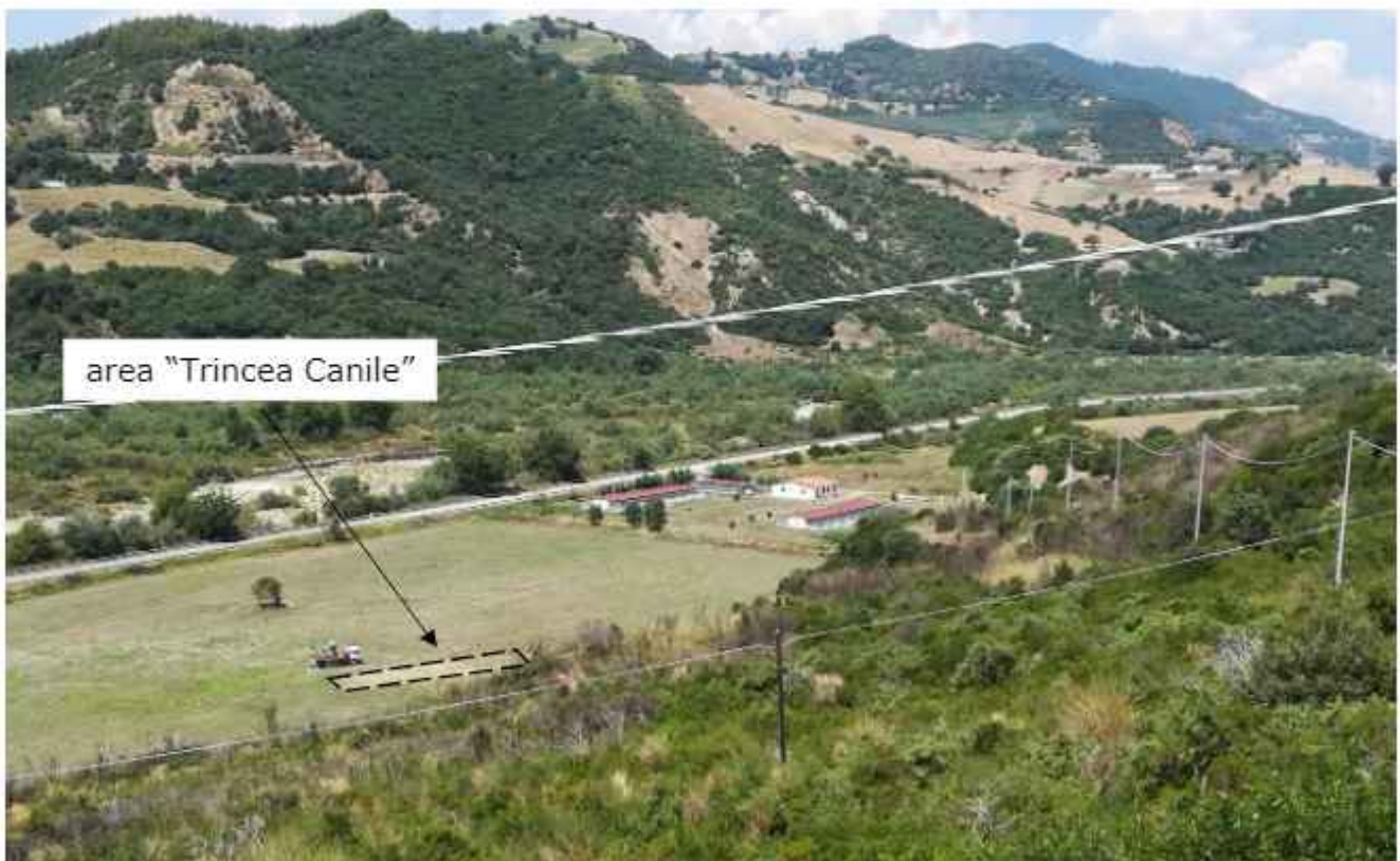
Figura 5.21 - Panoramica del Sito Canile con evidenziata in nero l'area di scavo "Trincea Canile".
