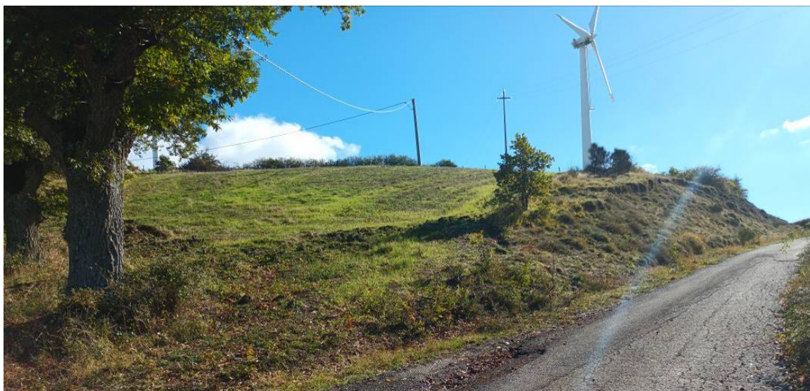
Foto 7 – Strada di accesso e percorso flowline
