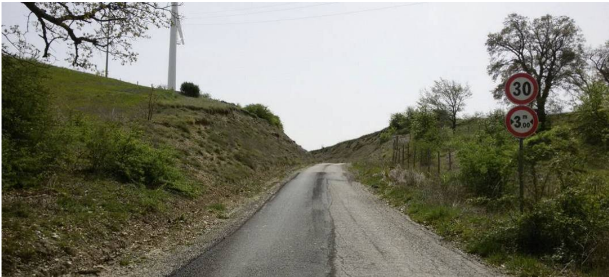
Foto 6 – Strada di accesso e percorso flowline
