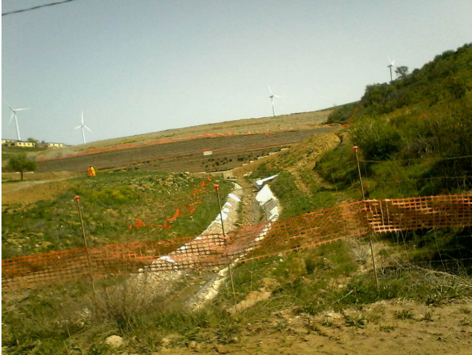
Foto 13 – Opera di sistemazione fosso di ruscellamento
