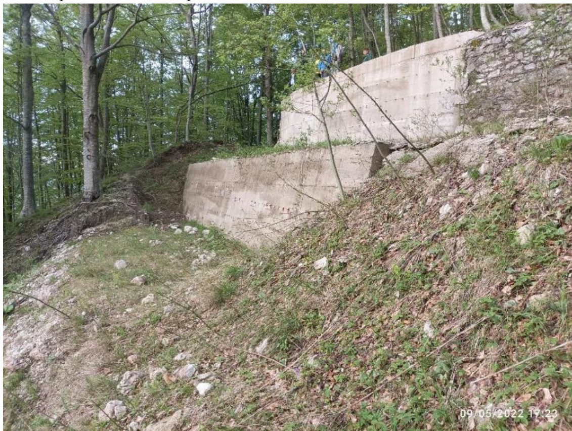
Foto 4 Superfici da rivestire in pietrame
