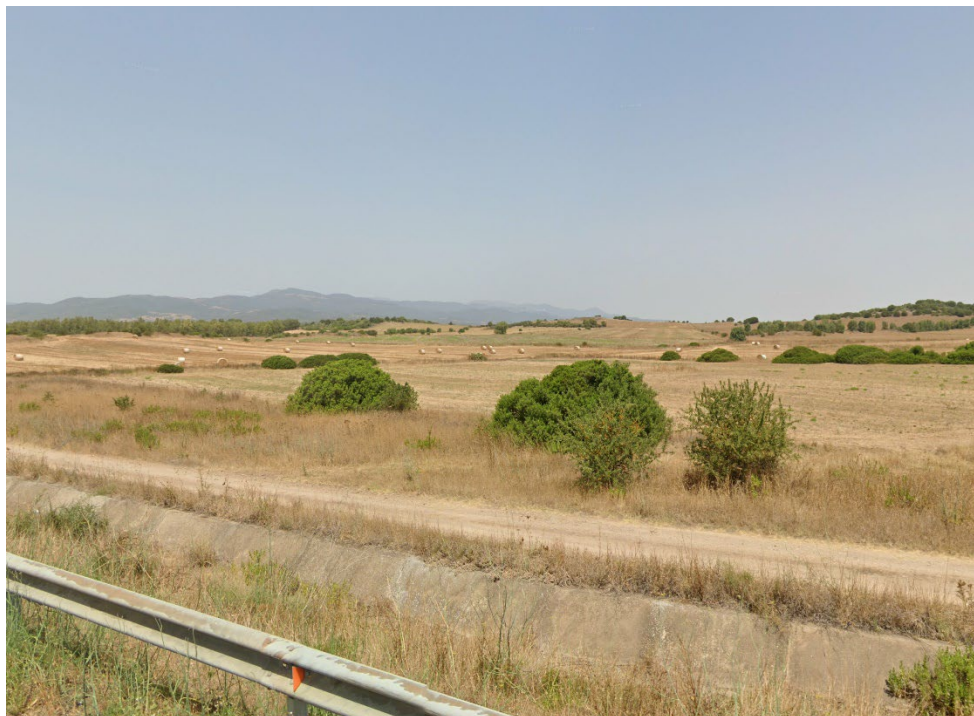
Figura 28 - Esempio vista ante-operam
