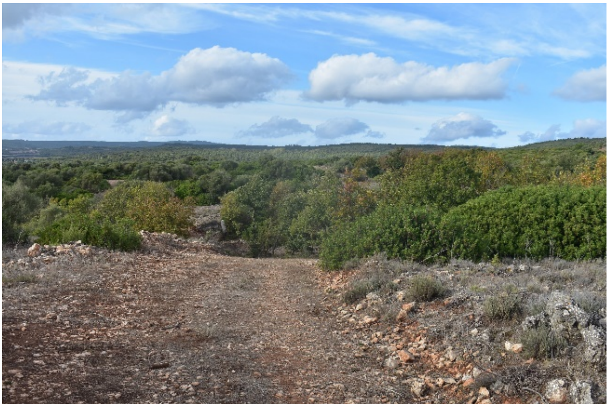
Figura 38 - Tratturo preesistente di servizio per l'accesso al fondo in cui si prevede la realizzazione della viabilità novativa
