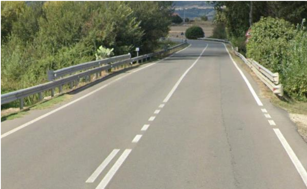
Punto di attraversamento 4 con il Riu Cannisoni
