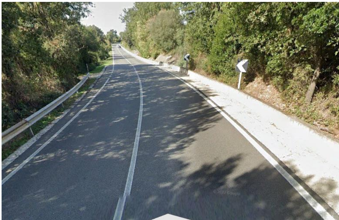
Punto di attraversamento 5 con il 02116 FIUME 38757
