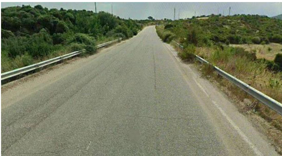
Punto di attraversamento 8 con il Riu Roledu
