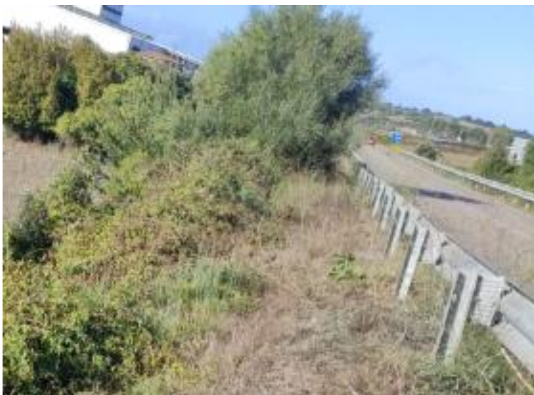
Punto di attraversamento 10 con il Riu Bau Carru
