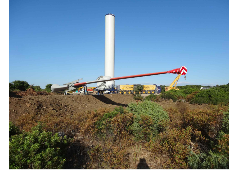
ESEMPIO DI AREA STOCCAGGIO PALE 1
