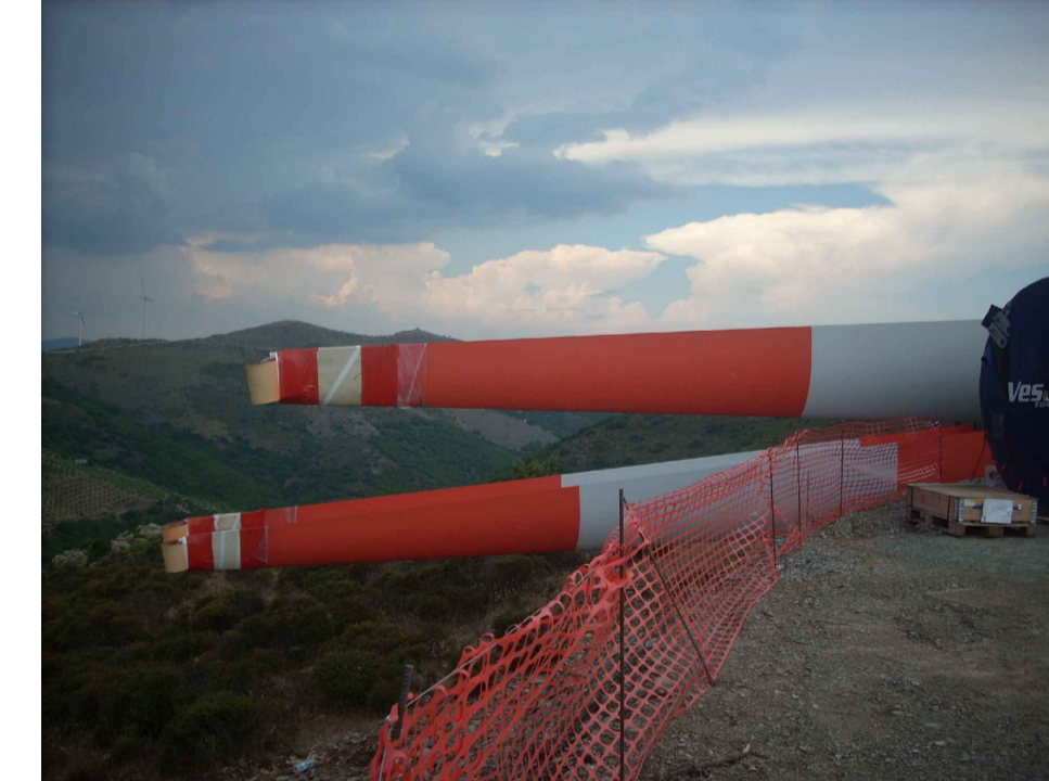
ESEMPIO DI AREA STOCCAGGIO PALE 3
