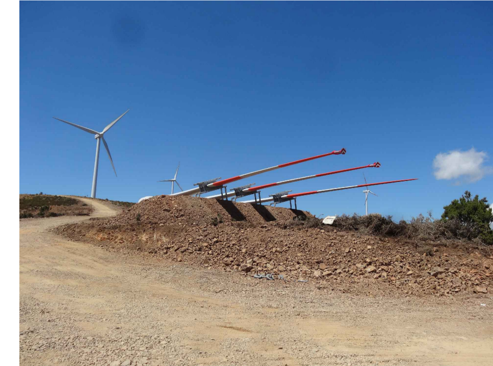
ESEMPIO DI AREA STOCCAGGIO PALE 5
