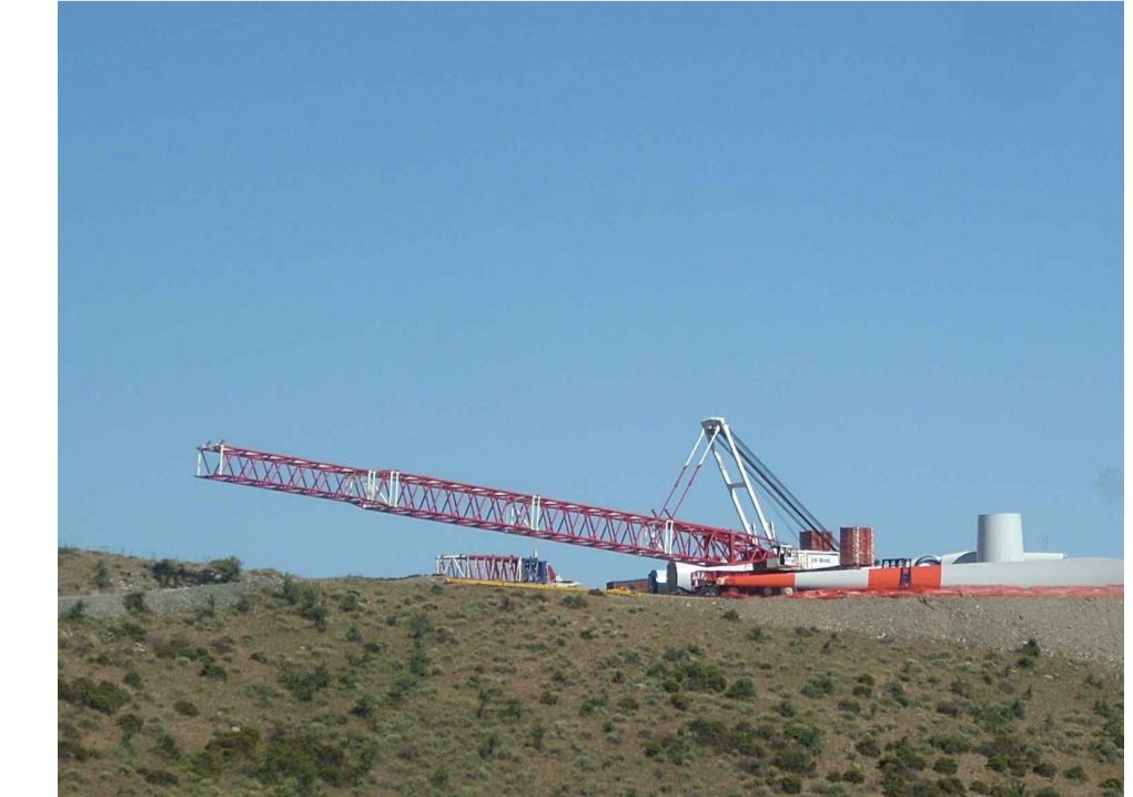
ESEMPIO DI AREA DI INGOMBRO BRACCIO DELLA GRU PRINCIPALE
