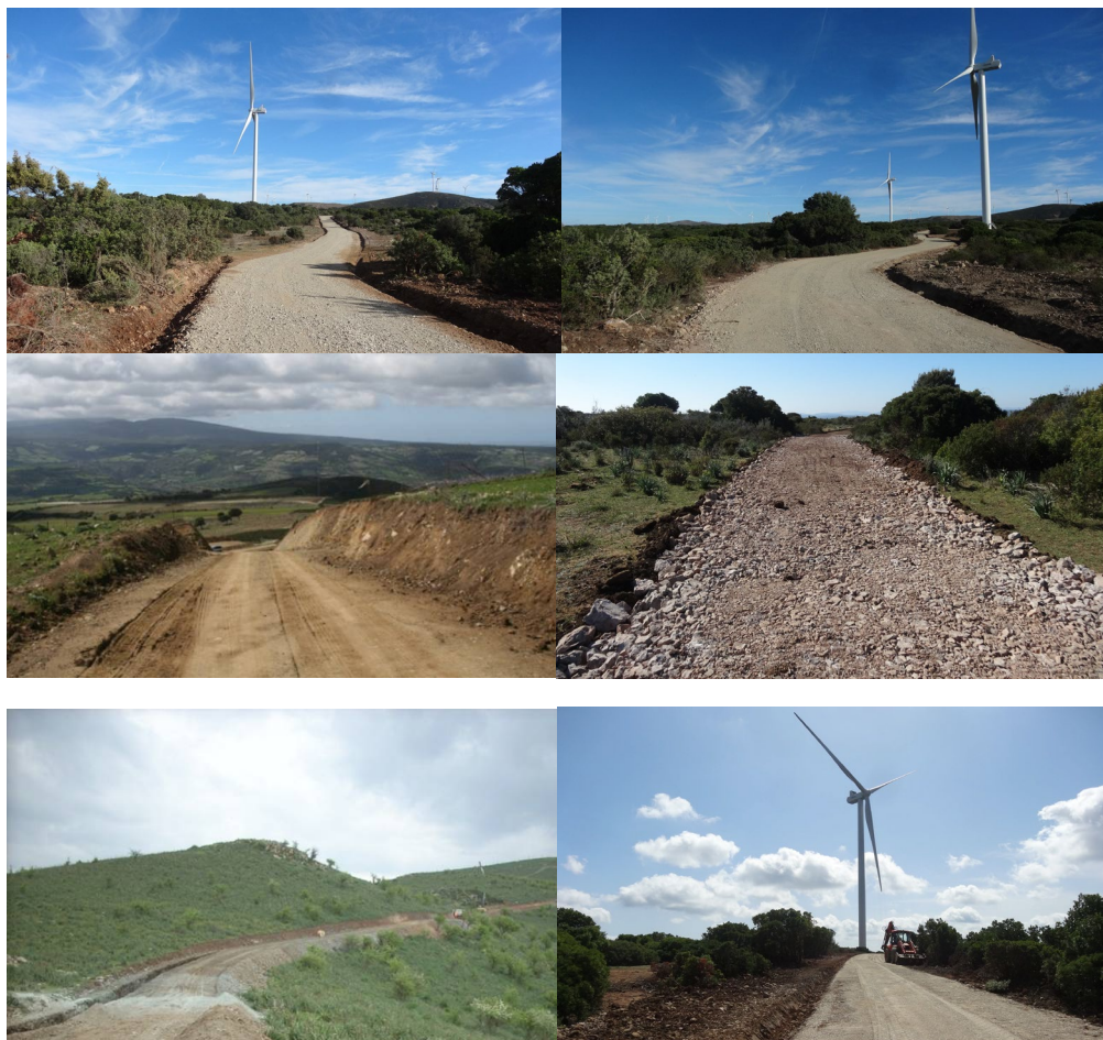
FIG. 21 – REALIZZAZIONI TIPICHE DI STRADE PER PARCHI EOLICI
