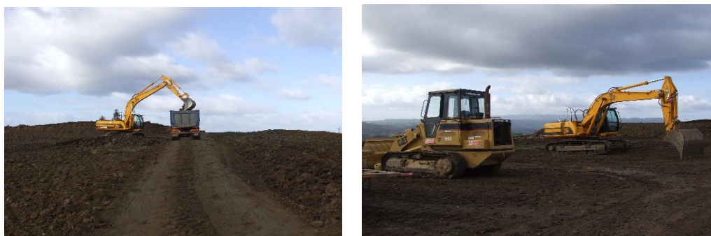
FIG. 31 – OPERAZIONI DI REALIZZAZIONE PIAZZOLE
