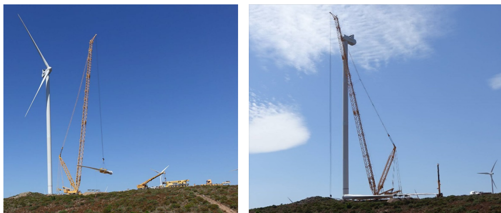
FIG. 33 – OPERAZIONI DI MONTAGGIO CON GRU
