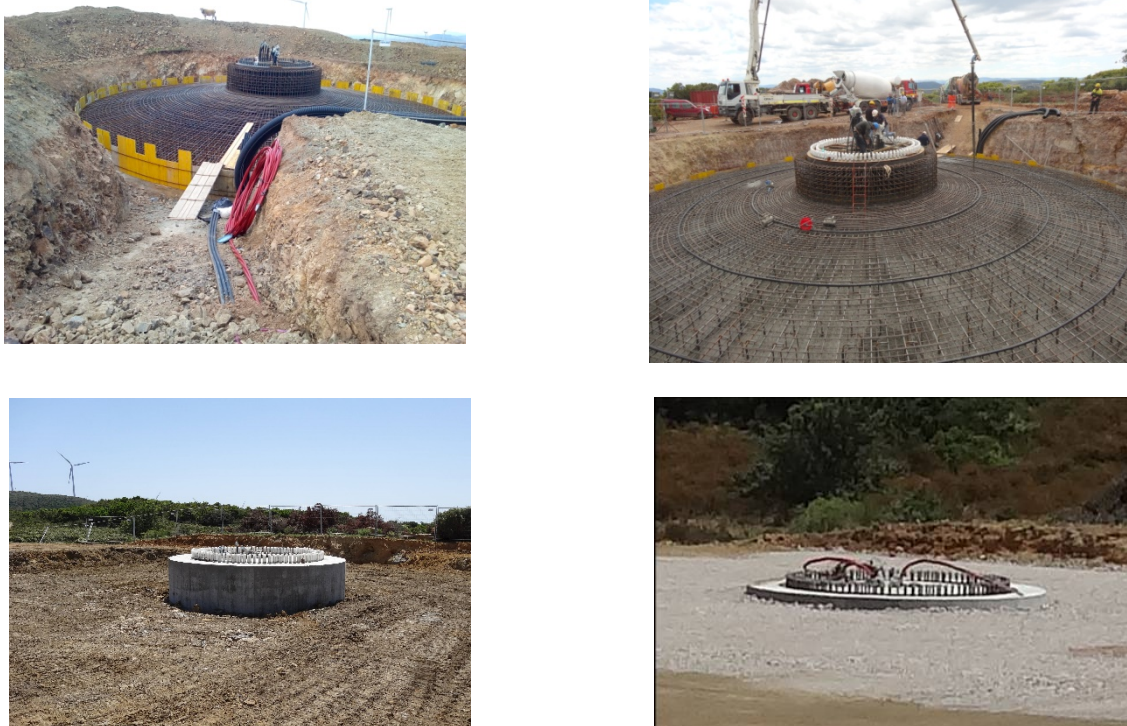
FIG. 27 – FASI REALIZZATIVE FONDAZIONI
