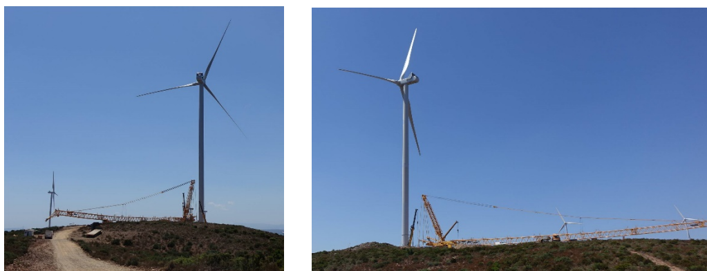
FIG. 30 – SPAZI DI MONTAGGIO PER LA GRU PRINCIPALE
