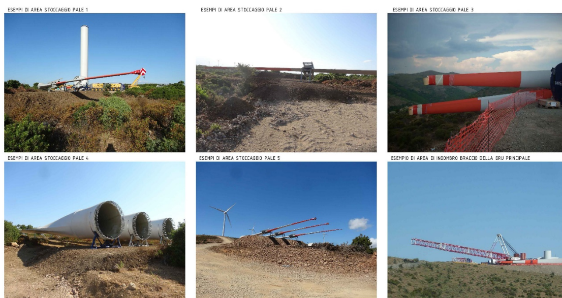
FIG. 28 – ESEMPI DI STOCCAGGIO PALE
