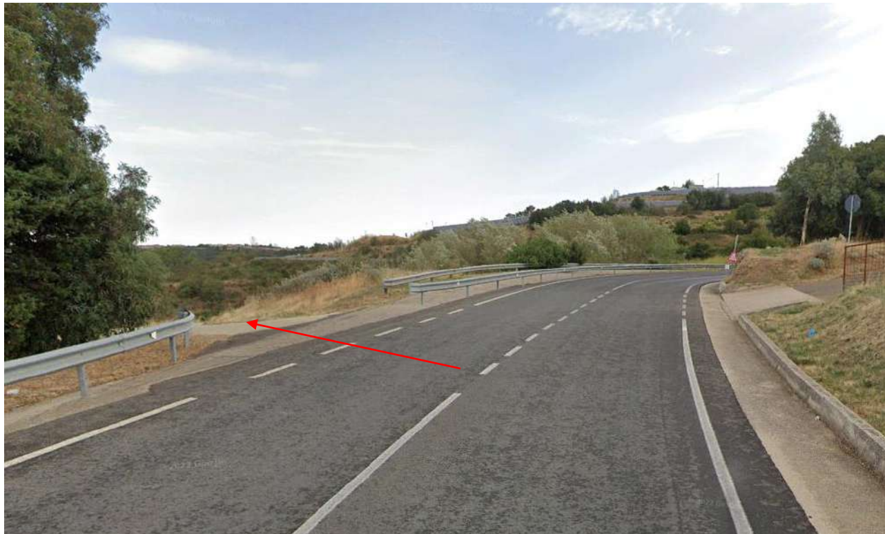
Punto di innesto della viabilità locale di accesso alle postazioni eoliche WTG9, WTG11 e WTG10 – nella porzione meridionale dell’impianto – a partire dalla SS 128. Foto estrapolata da Google Earth con vista da nord verso sud
