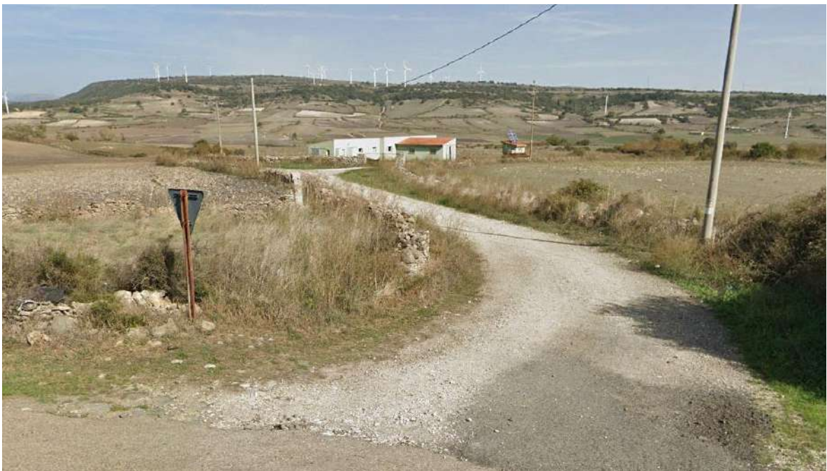
Tracciato rurale esistente di accesso alla postazione eolica WTG6
