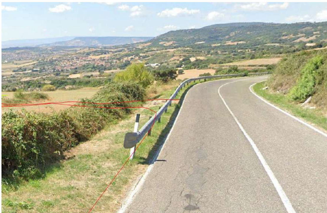
Punto su cui si attesta la viabilità di nuova costruzione di accesso alla postazione WTG8 (direzione nord)
