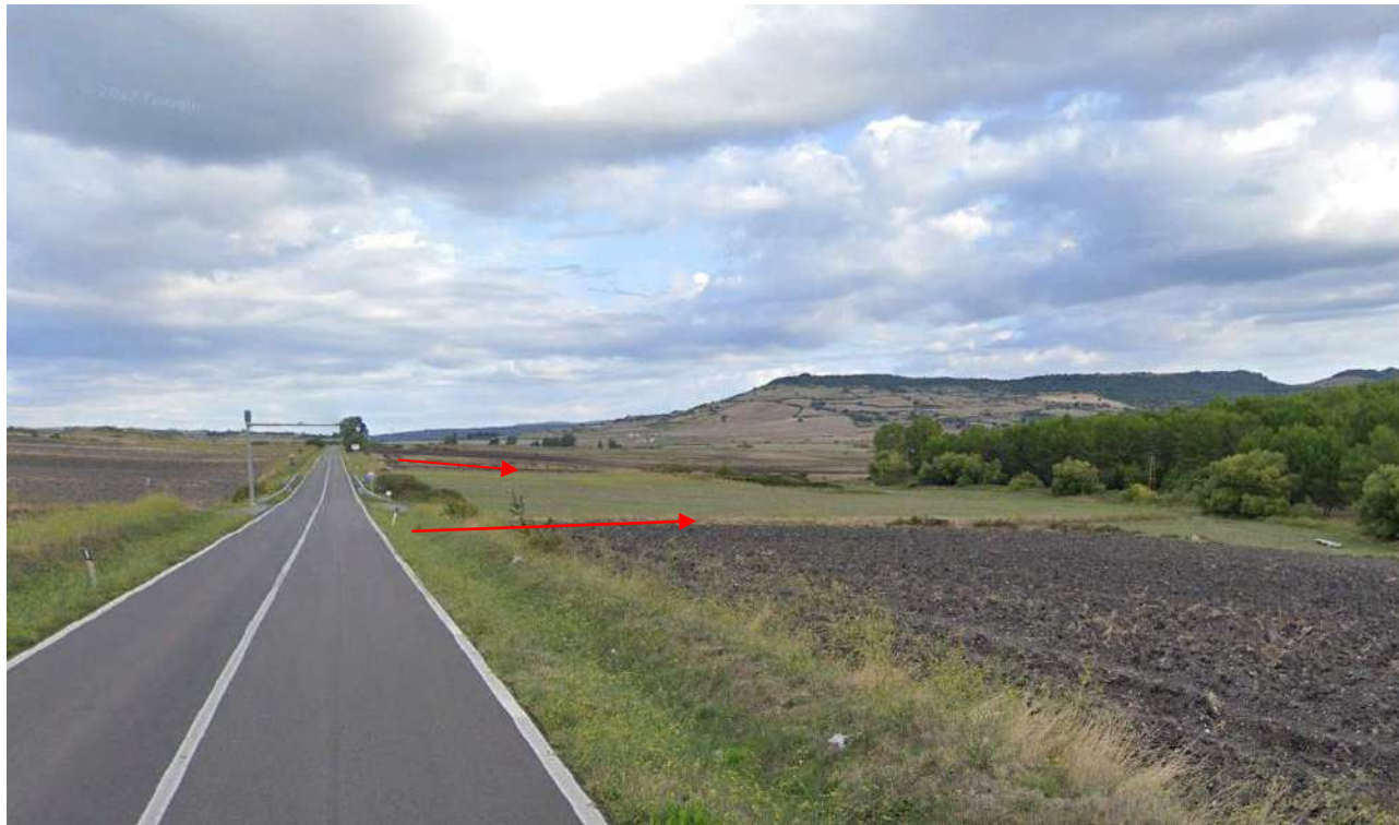
Punti di innesto della viabilità di nuova realizzazione sull’asse della SS 128 per garantire l’accesso ai WTG2 (in primo piano) e WTG1 (in secondo piano). Foto estrapolata da Google Earth con vista da sud-est verso nord-ovest
