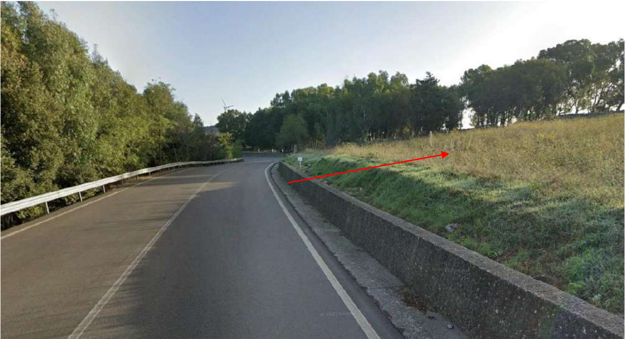
Punto di innesto della viabilità di nuova realizzazione di accesso alla postazione eolica WTG13 a partire dalla SS 128. Foto estrapolata da Google Earth con vista da sud verso nord
