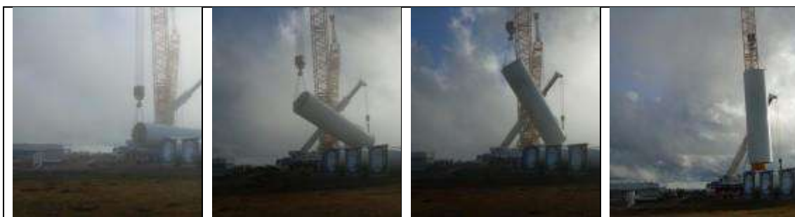
Schema delle fasi di sollevamento dei componenti dell'aerogeneratore (Fonte sito web http://www.windfarmbop.com/ )
