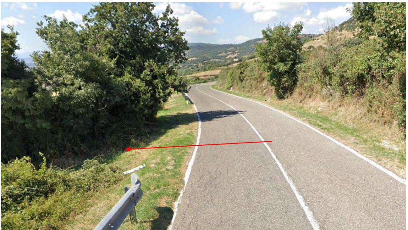
Punto di innesto della viabilità di nuova realizzazione di accesso alla postazione eolica WTG8 a partire dalla SP 9. Foto estrapolata da Google Earth con vista da ovest verso est
