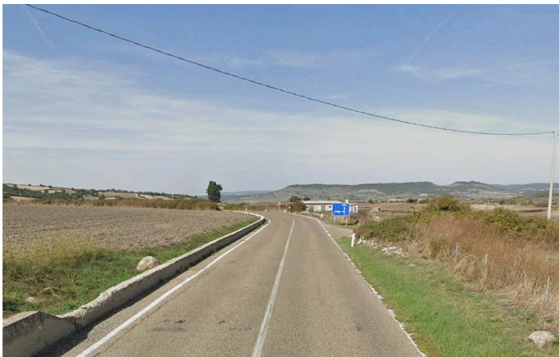
Accesso dalla viabilità esistente S.S 128 – Centrale Sarda (direzione nord)
