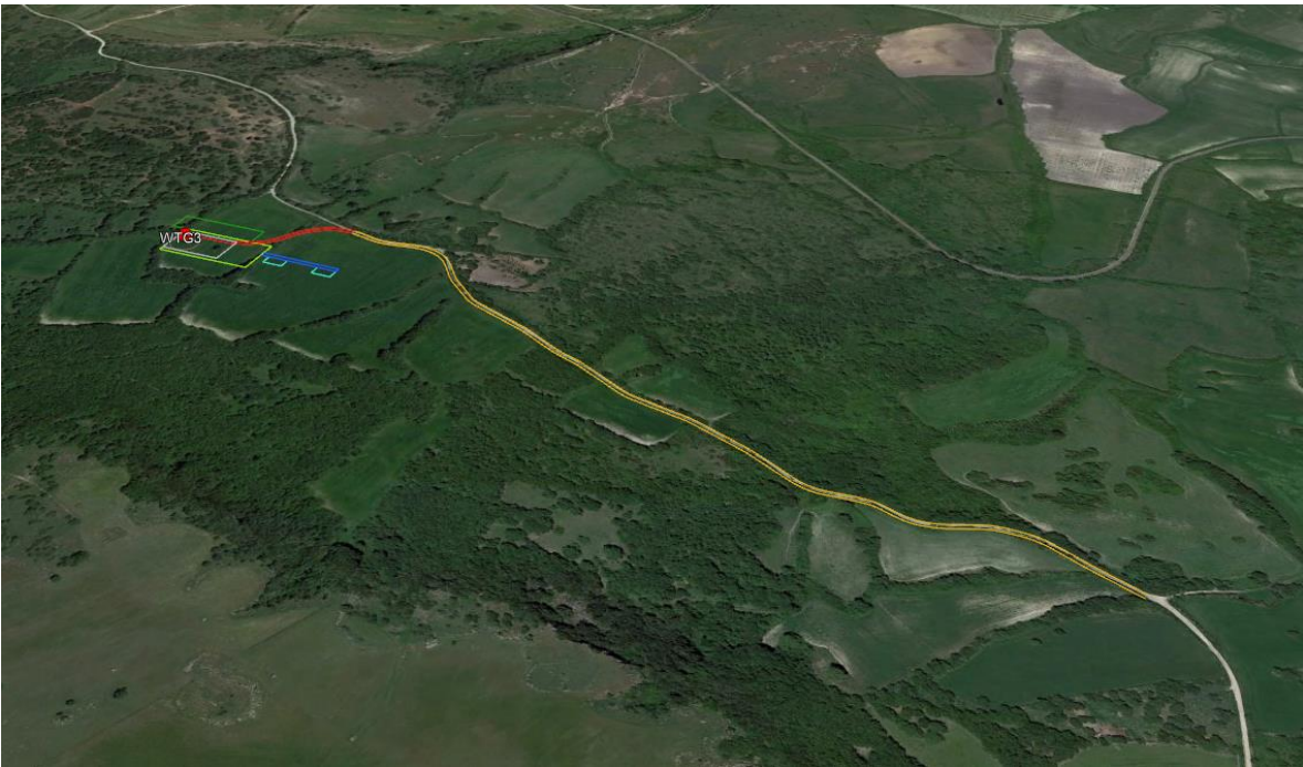
Asse di collegamento alla postazione eolica WTG3 (vista da sud)
