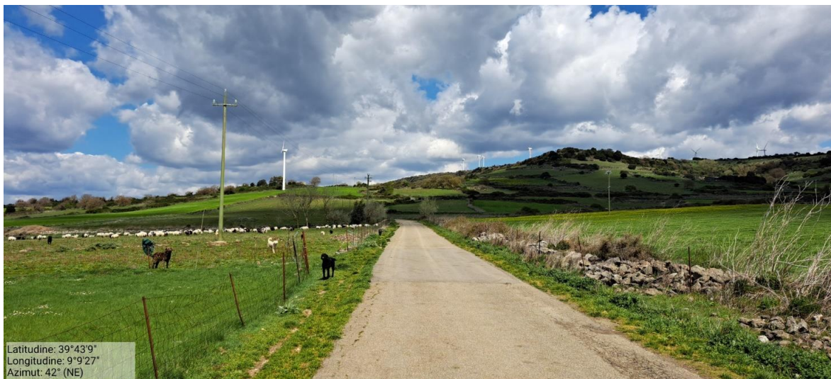
Esistente strada vicinale Putzu Pani, di accesso collegamento con la postazione eolica WTG4 (direzione nord-est)
