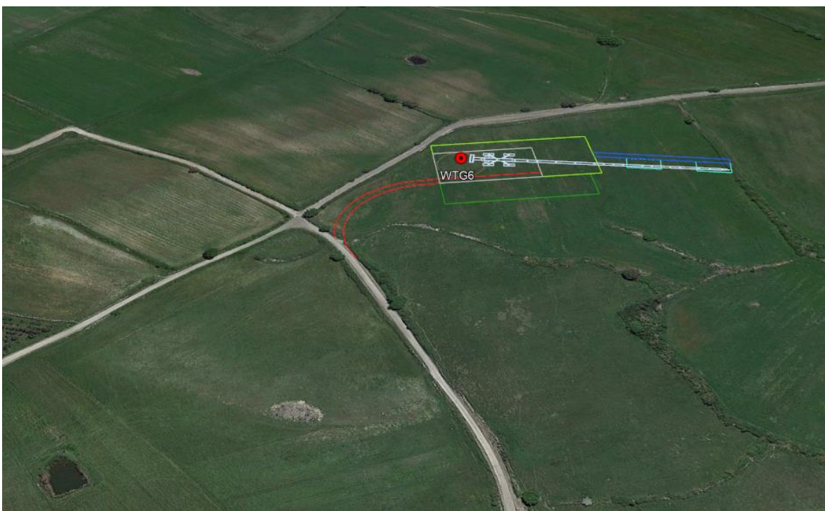
Terreni agricoli attraversati dalla nuova viabilità in corrispondenza della postazione WTG6 Raccordo di accesso all'asse di collegamento della postazione WTG4
