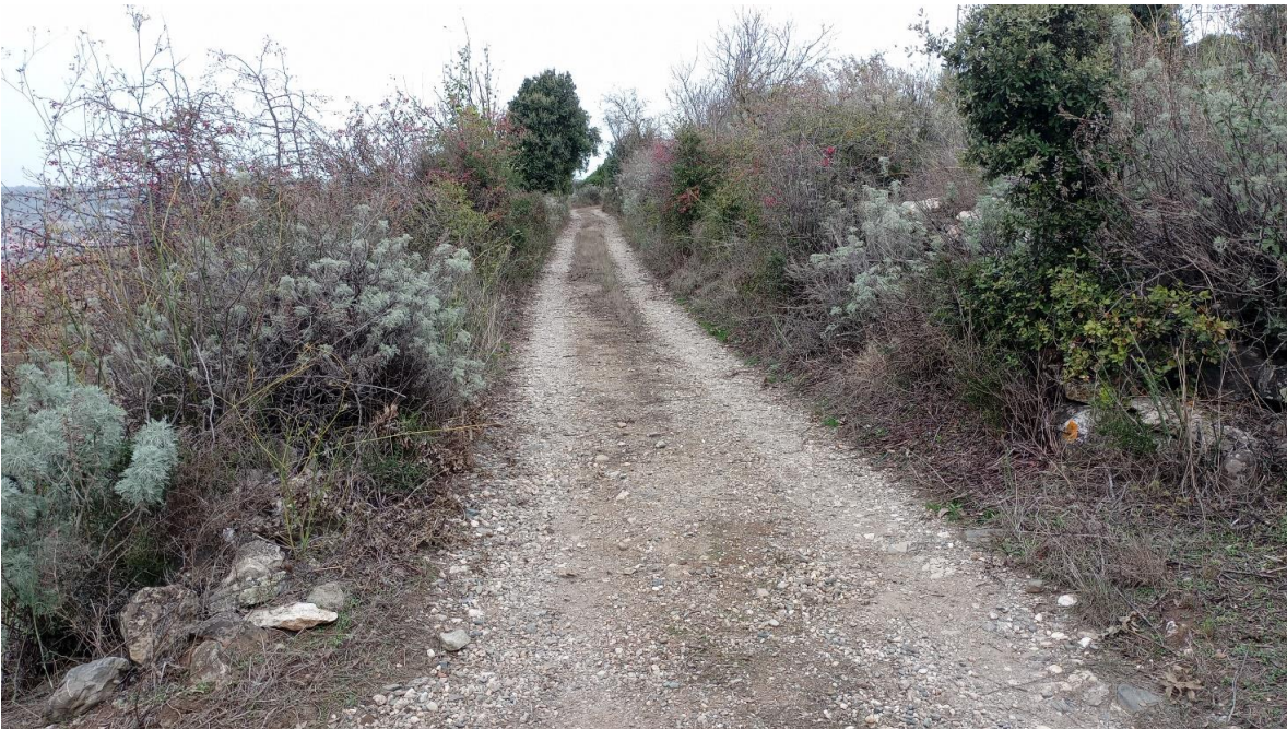
Tratturo campestre in adeguamento di accesso alla postazione WTG11 (direzione nord-ovest)
