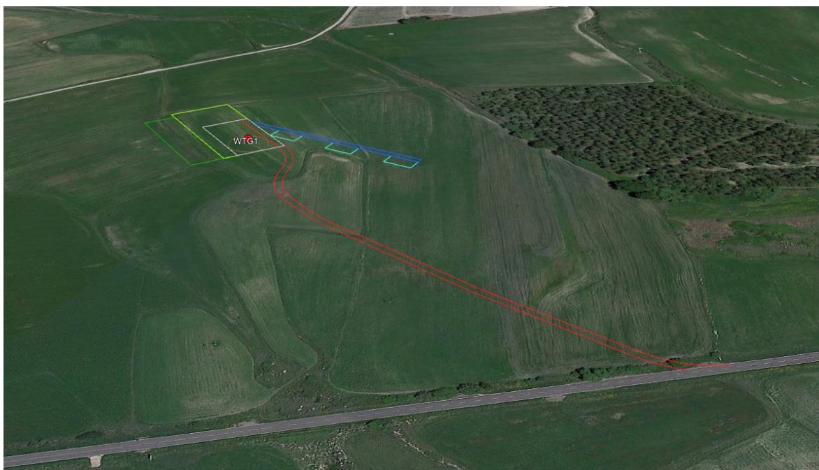
Asse di collegamento alla postazione eolica WTG1 (vista da nord-ovest)
