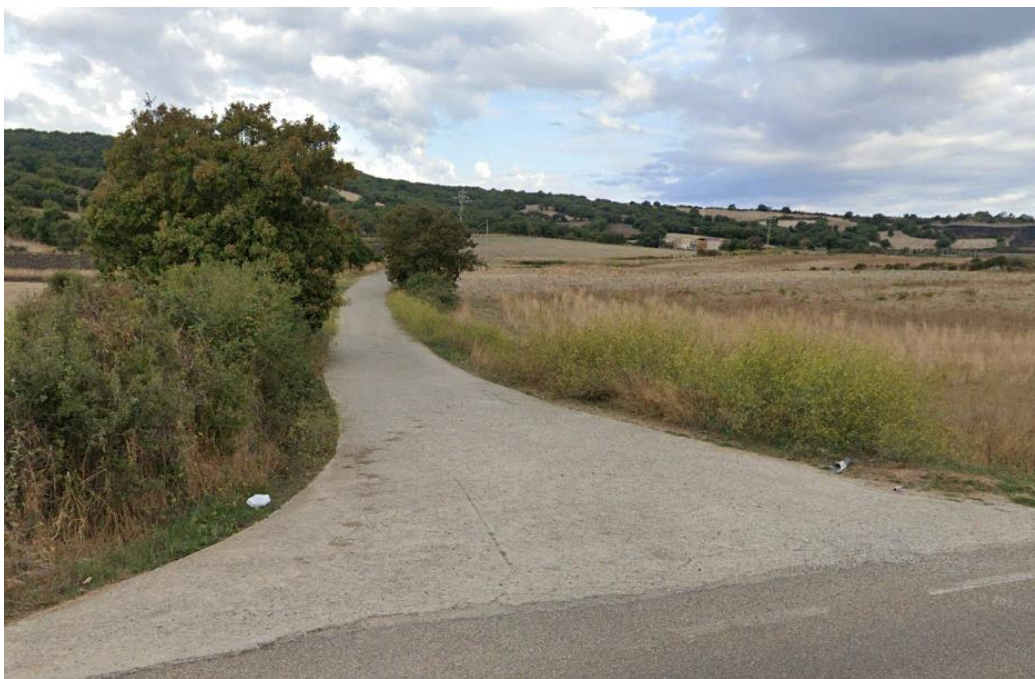
Tratturo bitumato di accesso alle postazioni eoliche WTG5 e WTG3 (direzione ovest)
