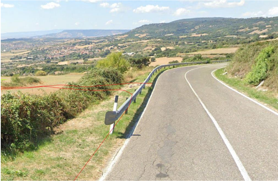
Punto su cui si attesta la viabilità di nuova costruzione di accesso alla postazione WTG8 (direzione nord)
