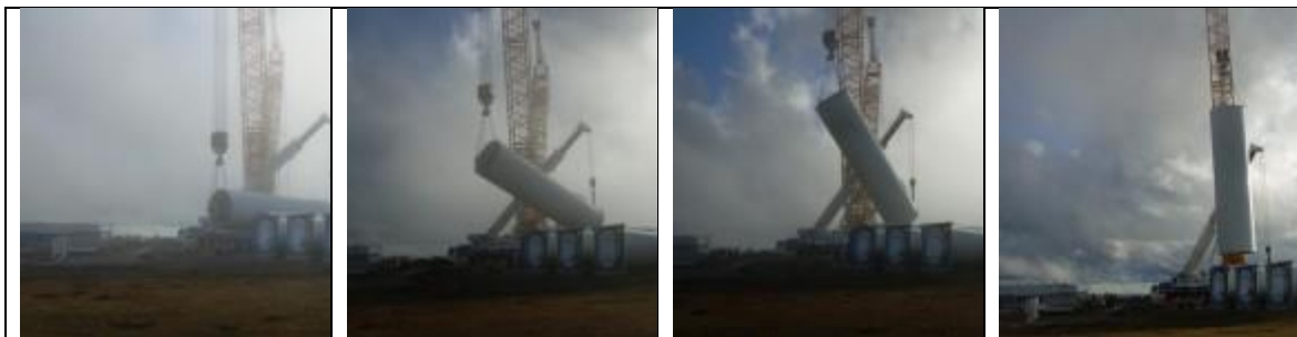
Schema delle fasi di sollevamento dei componenti dell'aerogeneratore (Fonte sito web http://www.windfarmbop.com/ )
