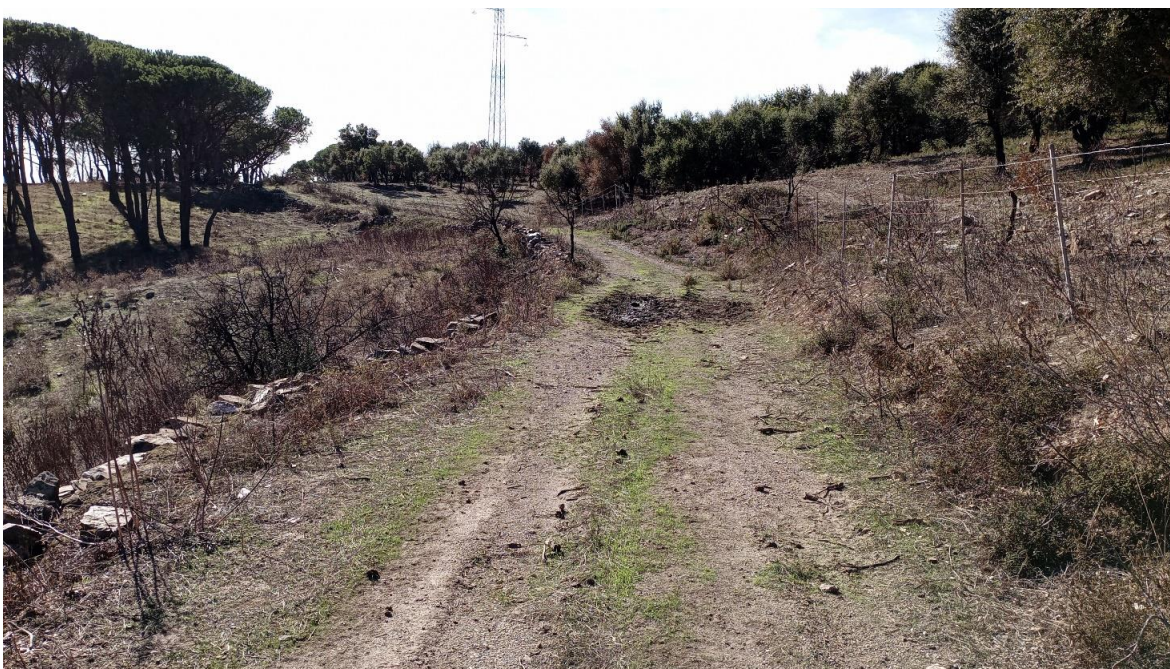
Tratturo campestre in adeguamento di collegamento alla postazione WTG13 (direzione est)
