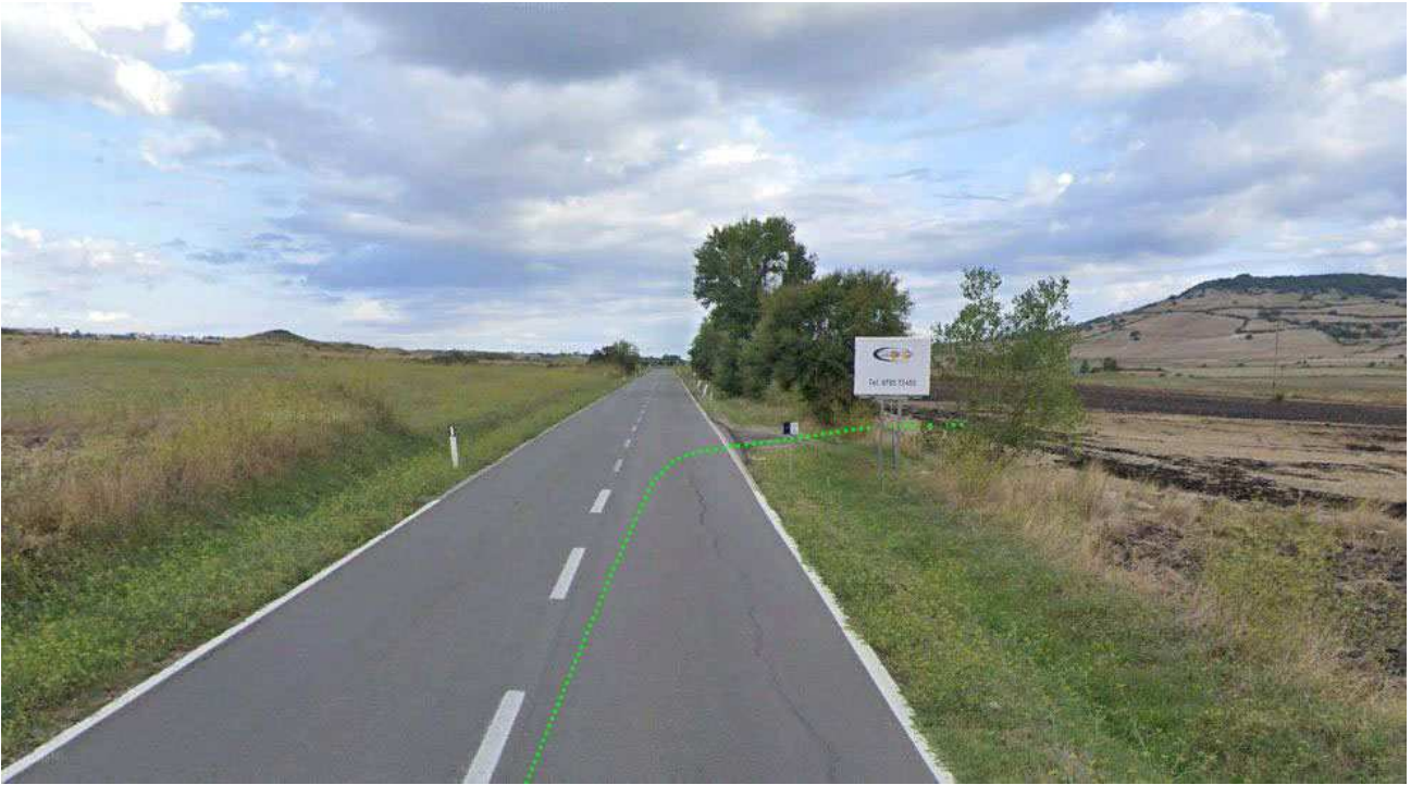
Punto di accesso all'asse di collegamento della postazione eolica WTG1 (direzione nord)
