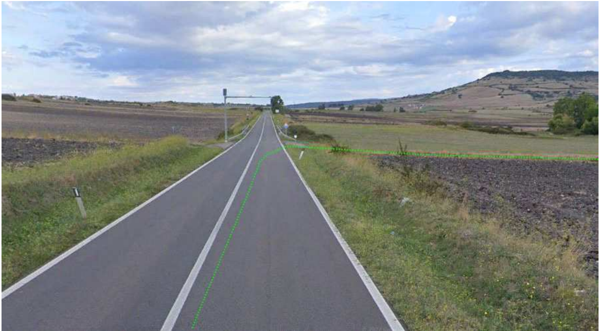
Punto di accesso dalla S.S. 128 di collegamento alla postazione eolica WTG2 (direzione nord)
