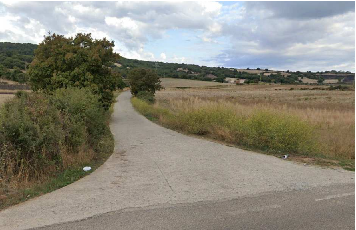
Tratturo bitumato di accesso alle postazioni eoliche WTG5 e WTG3 (direzione ovest)
