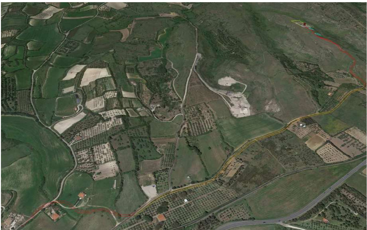
Asse di collegamento alla postazione eolica WTG11 (vista da sud-est)
