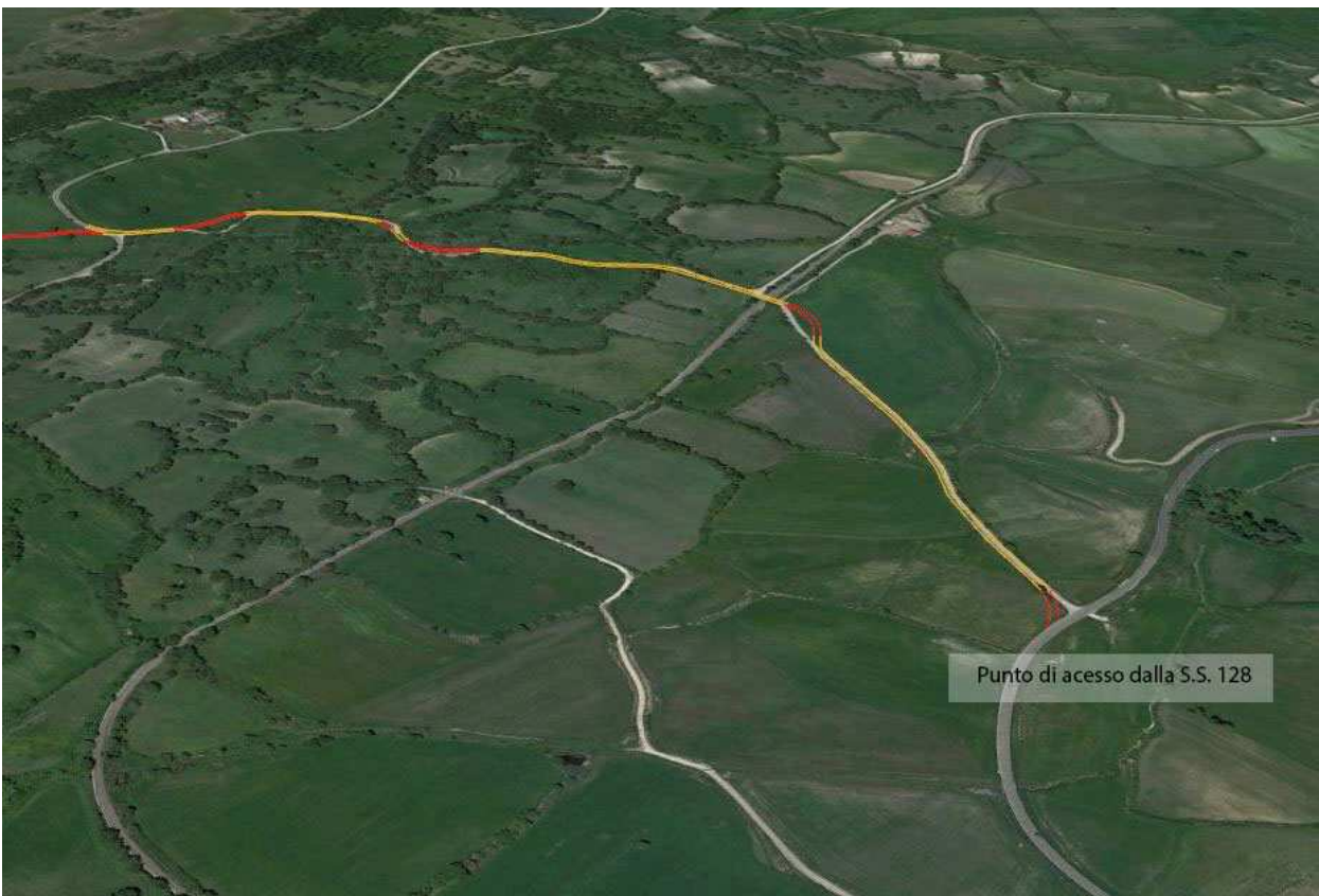
Viabilità di collegamento agli assi di accesso delle postazioni eoliche WTG5 e WTG3
