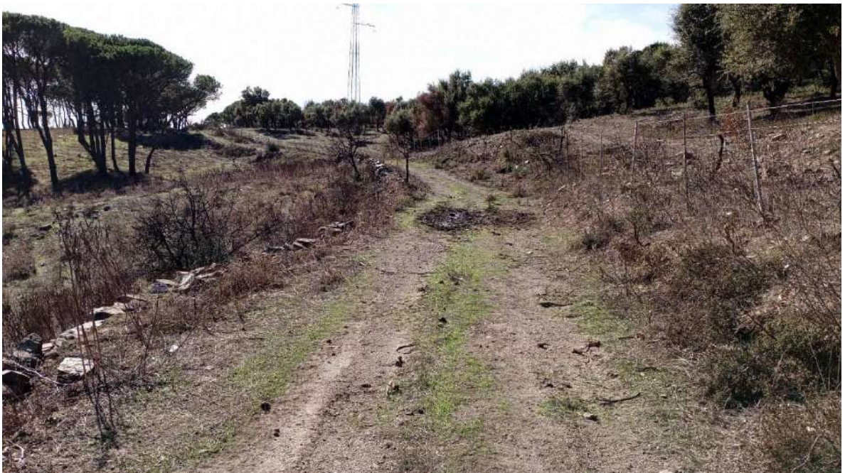
Tratturo campestre in adeguamento di collegamento alla postazione WTG13 (direzione est)
