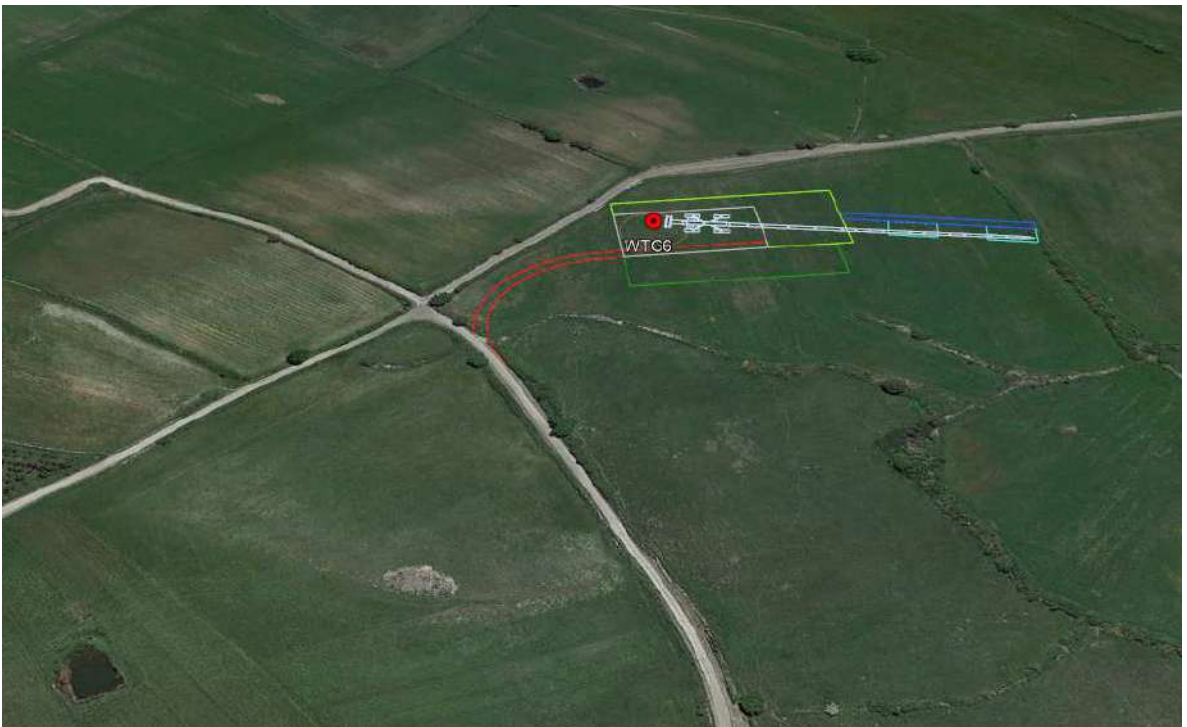
Terreni agricoli attraversati dalla nuova viabilità in corrispondenza della postazione WTG6
