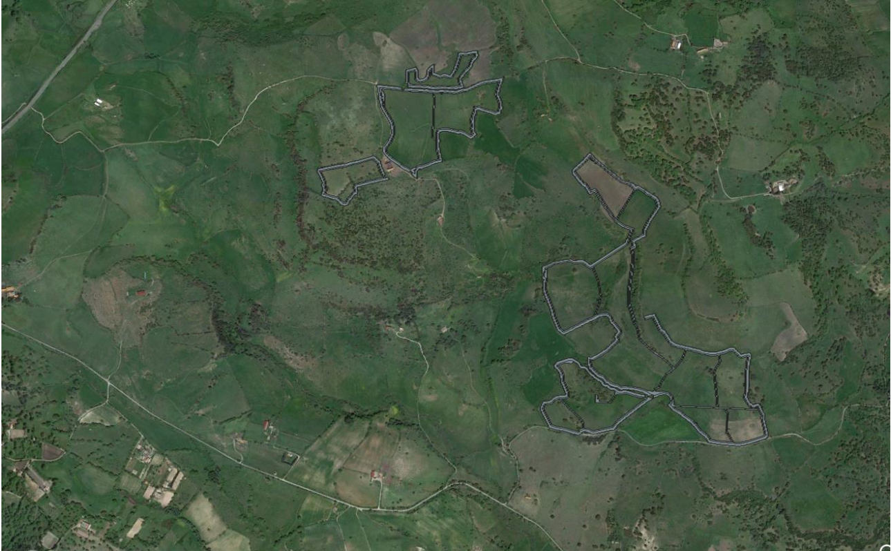
Figura 3: Vista dall'alto – Campo fotovoltaico
