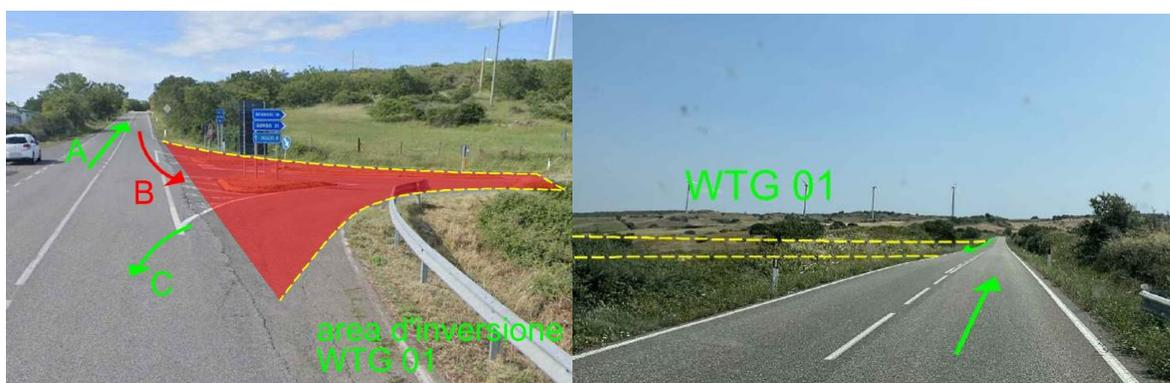
Fig. 13 – Accesso e adeguamento svincolo sulla SP127 per raggiungere l'accesso alla viabilità locale per la WTG AG\_01
