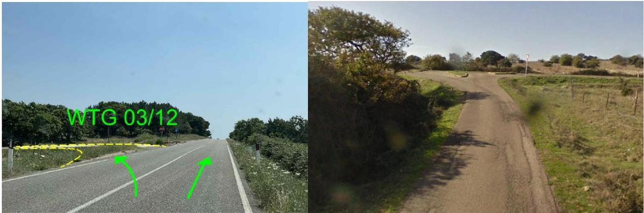
*Fig. 14 – Accesso e adeguamento svincolo sulla SP127 per raggiungere l'accesso alla viabilità locale per la WTG AG\_03/12*
