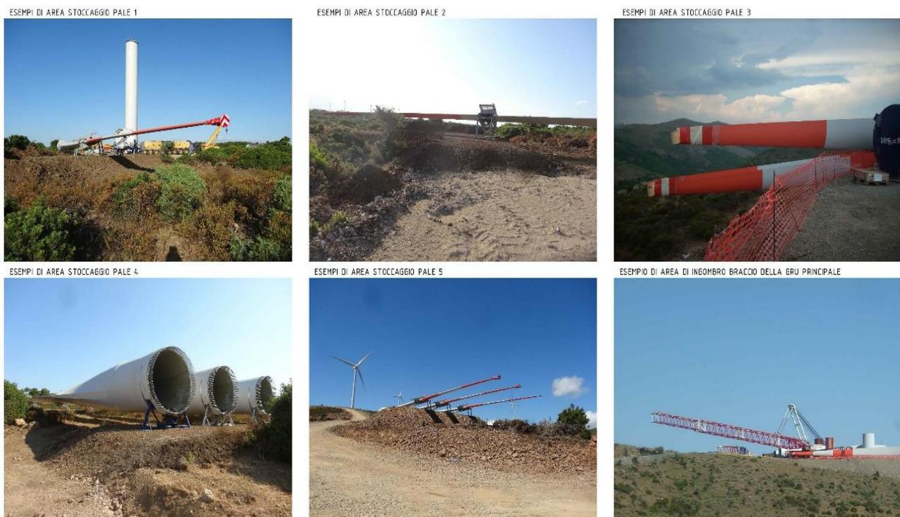
*Fig. 29 – Esempi di stoccaggio pale*
