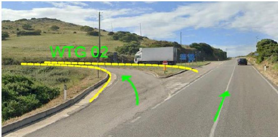
Fig. 12 – Adeguamento svincolo sulla SP17 per raggiungere l'accesso alla viabilità locale per la WTG AG\_02
