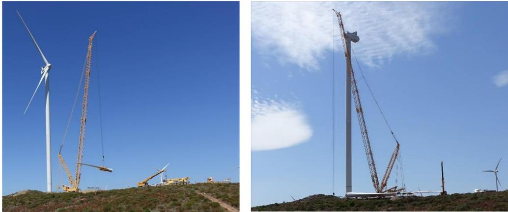
*Fig. 34 – Operazioni di montaggio con gru*
