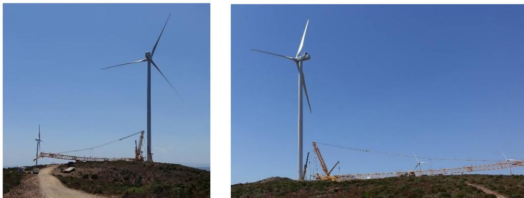
*Fig. 31 – Spazi di montaggio per la gru principale*
