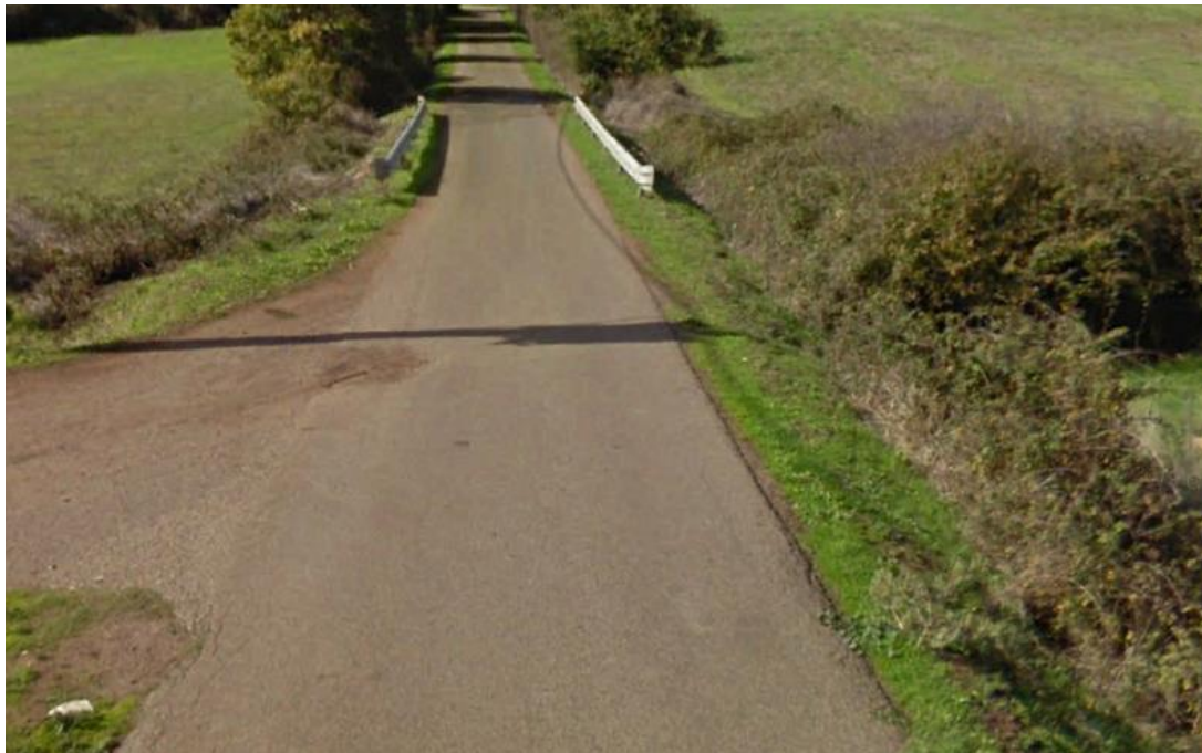
Punto di attraversamento 9 con il corso d'acqua Riu Pontisella
