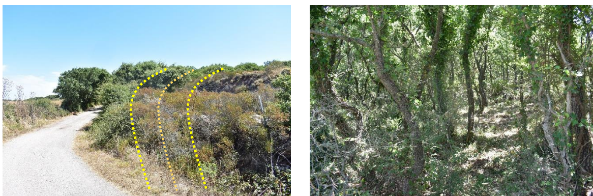
Figura 40 – Tratto stradale da sottoporre ad adeguamento stradale compreso tra la stazione AG05 e AG04
