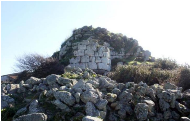
Figura 5. Il Nuraghe Alvu (bianco) è uno dei più interessanti del territorio per le sue tecniche costruttive abbastanza inconsuete e per l'utilizzo di due diversi tipi di conci, calcarei e trachitici, rozzamente sbozzati in basso ma ben squadri nella parte superiore.
