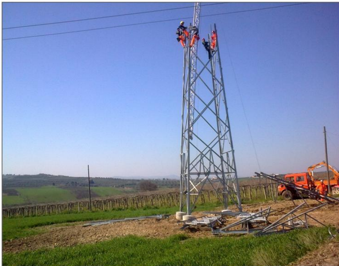
Figura 1.11 – Foto area di "micro cantiere" realizzazione sostegno.
