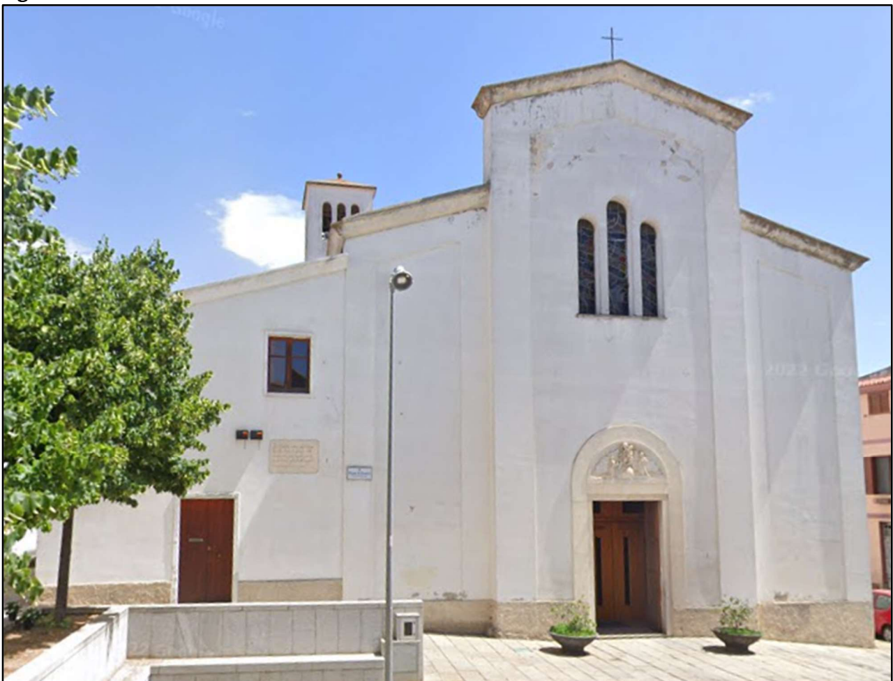
Figura 4.5.7: Chiesa di N.S. del Rosario nel centro abitato di Nuoro
