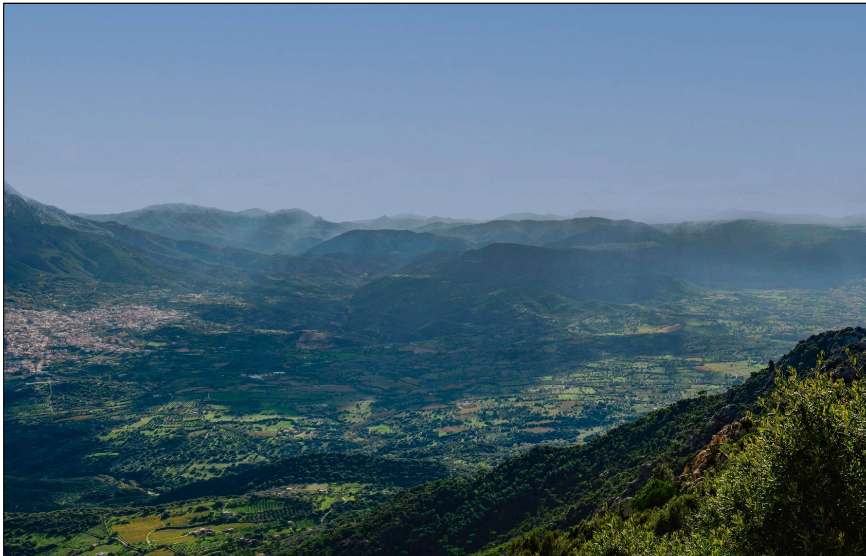
Foto 4a: Punto Panoramico verso Su Monte, Comune di Nuoro - punto di ripresa fotografica F04 - Long. 9,371386° e Lat. 40,320083° , Direzione foto 174° - Vista area Intero Parco Eolico ante operam
