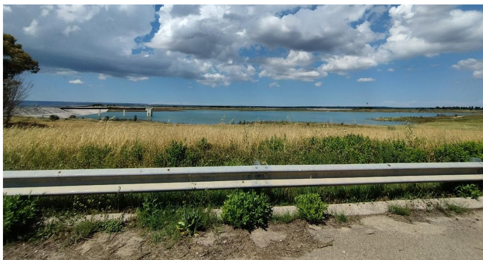
Foto 25: Inquadramento delle aree circostanti – invaso artificiale
