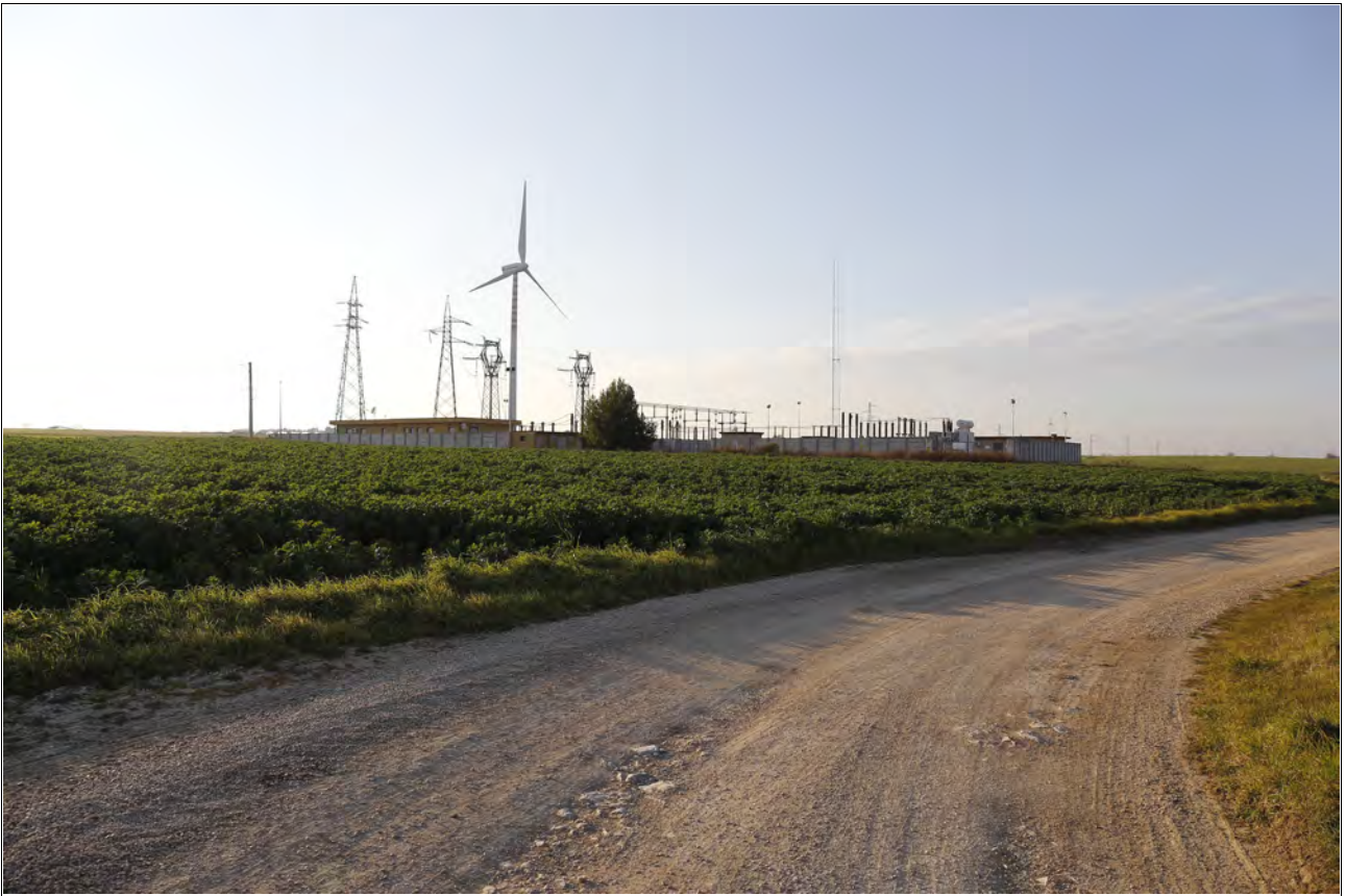
Figura 23 – Veduta della stazione elettrica che servirà l'impianto eolico, già presente nell'area d'indagine (Foto Studio Rocco Carella).
