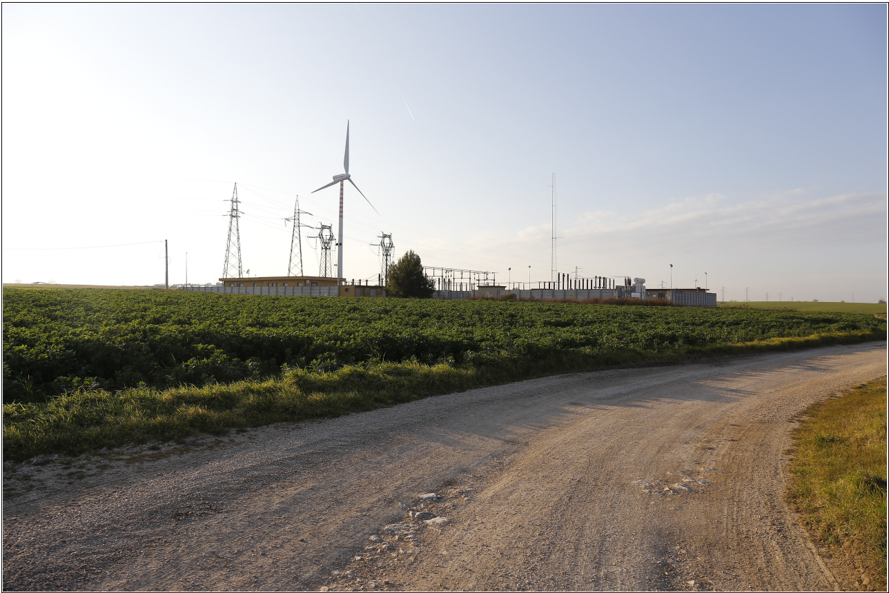
Figura 12 – Uno scorcio della già esistente sottostazione elettrica che servirà l'impianto ammodernato.
