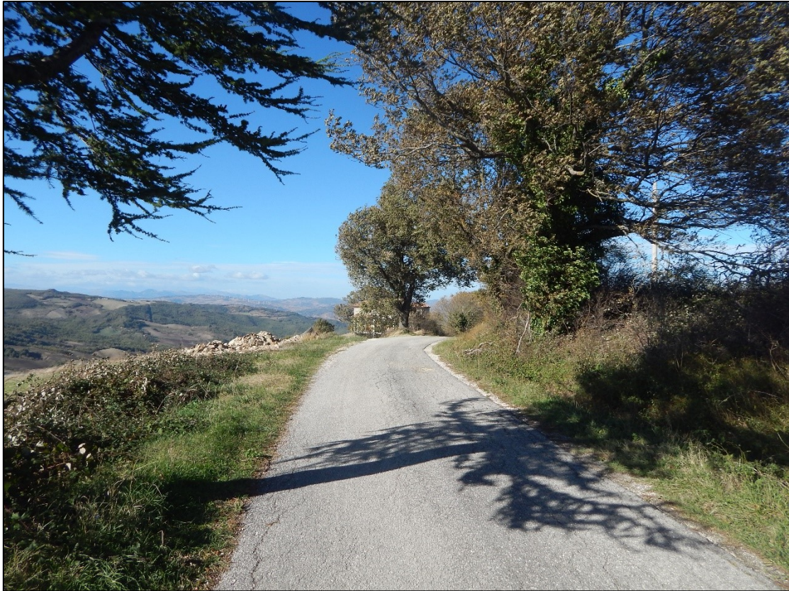
Figura 23 - Stato di fatto punto 1
