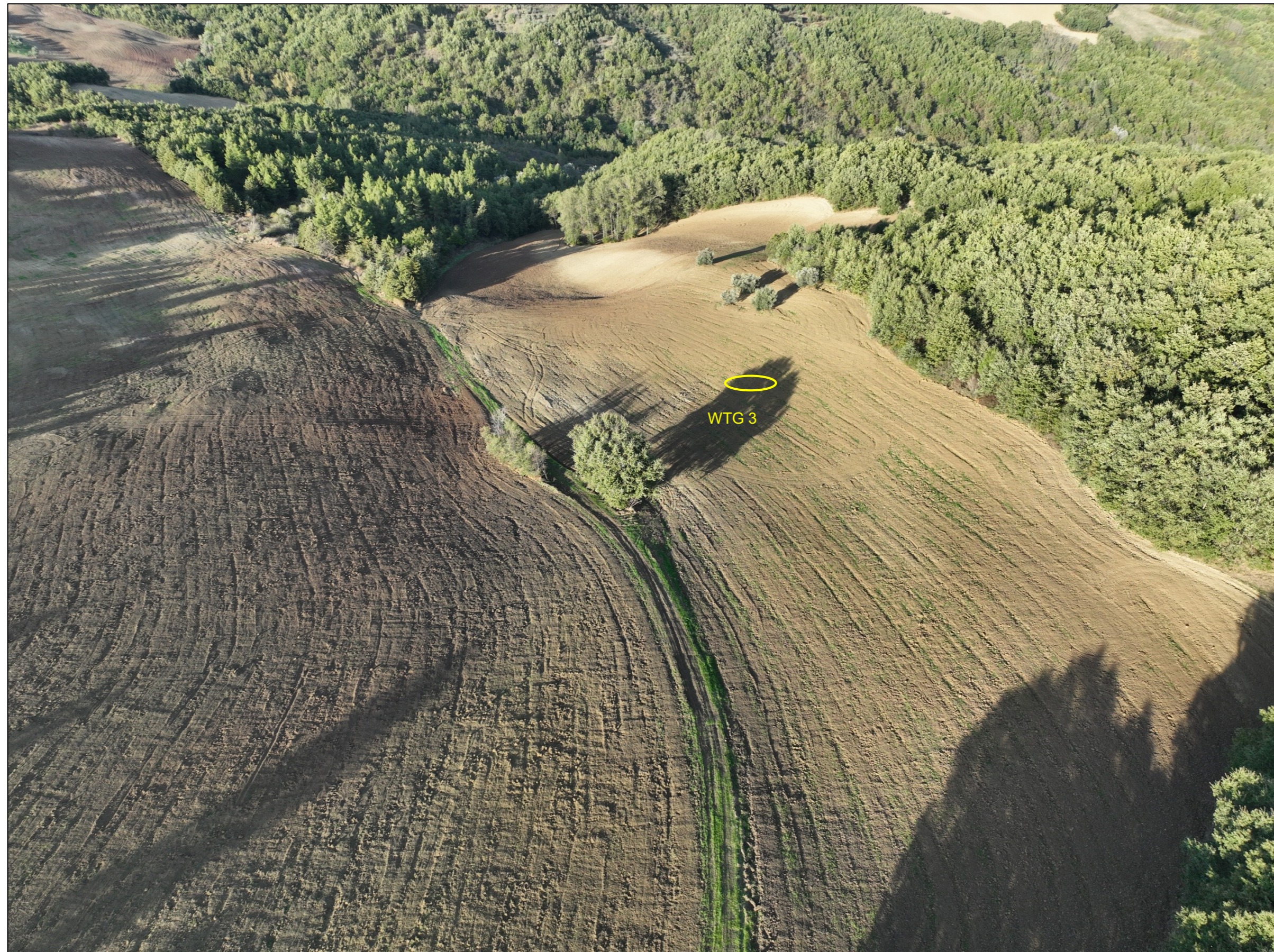
Figura 19 - Punto di scatto sito d'installazione WTG 3
