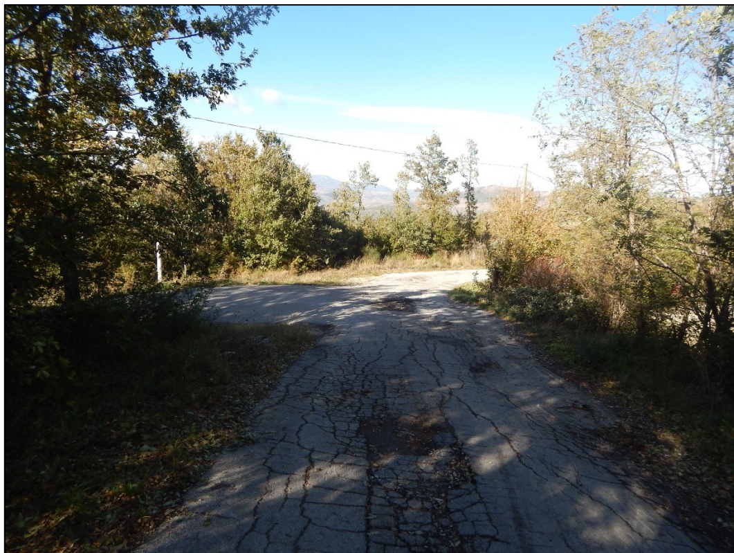
Figura 25 - Stato di fatto punto 3
