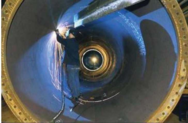
Figura 11: Interno di una torre
