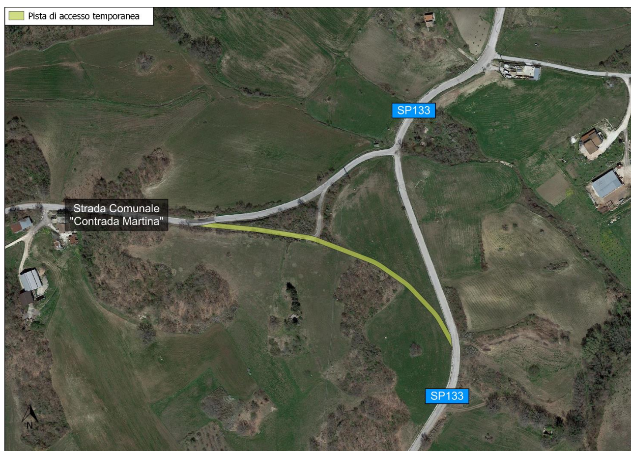
Figura 22 Pista di accesso temporanea all'impianto in fase di cantiere.
