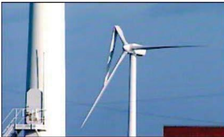
Esempio di rottura di pala senza distacco.
