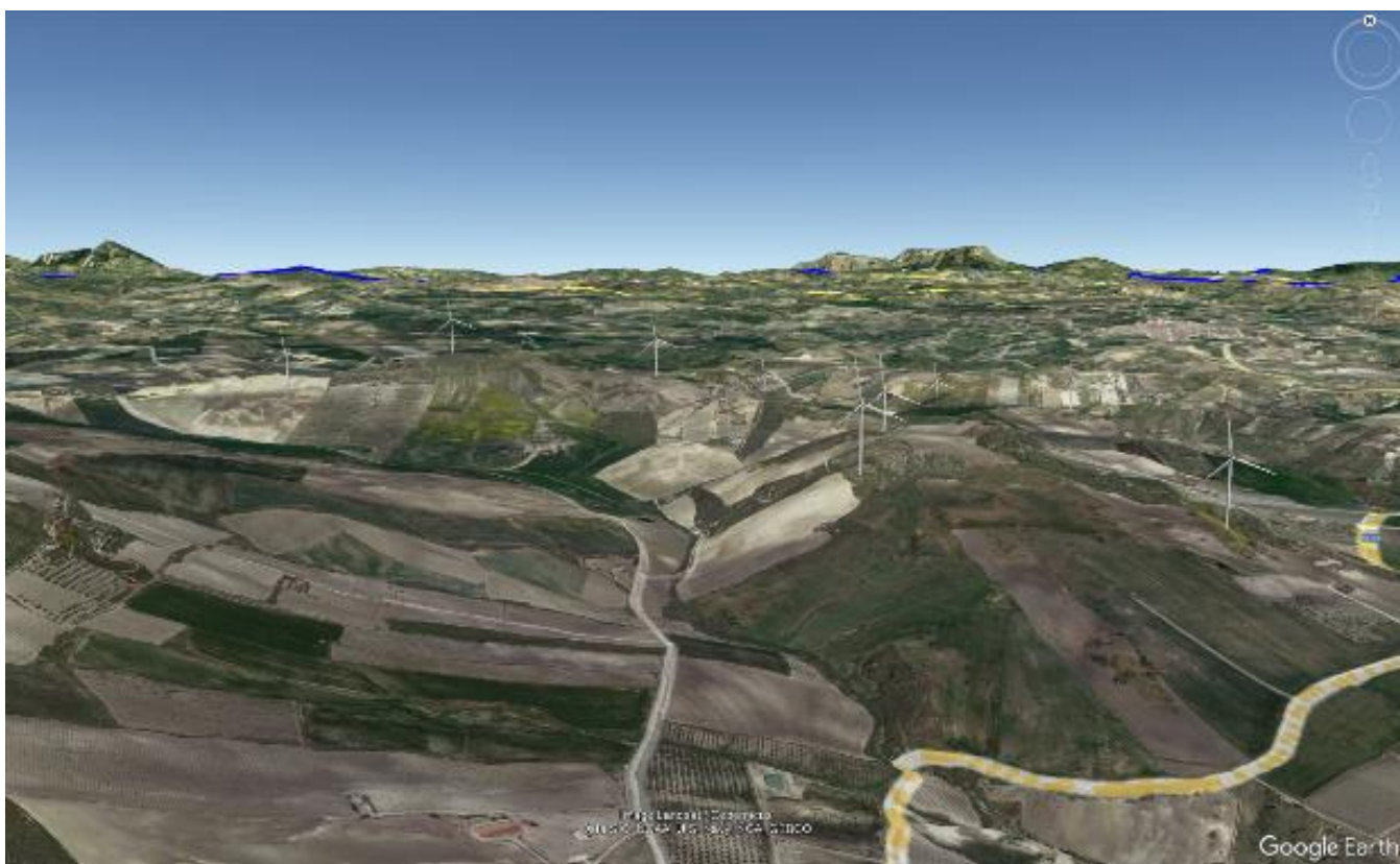
Figura 16 - Vista degli aerogeneratori – inquadratura sud-nord
