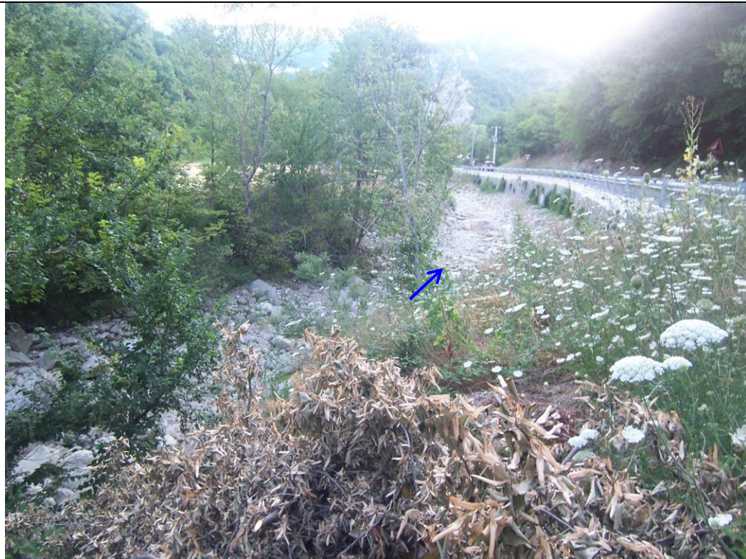
Foto 2: Zona attraversamento torrente Torbello – vista da destra idrografica
