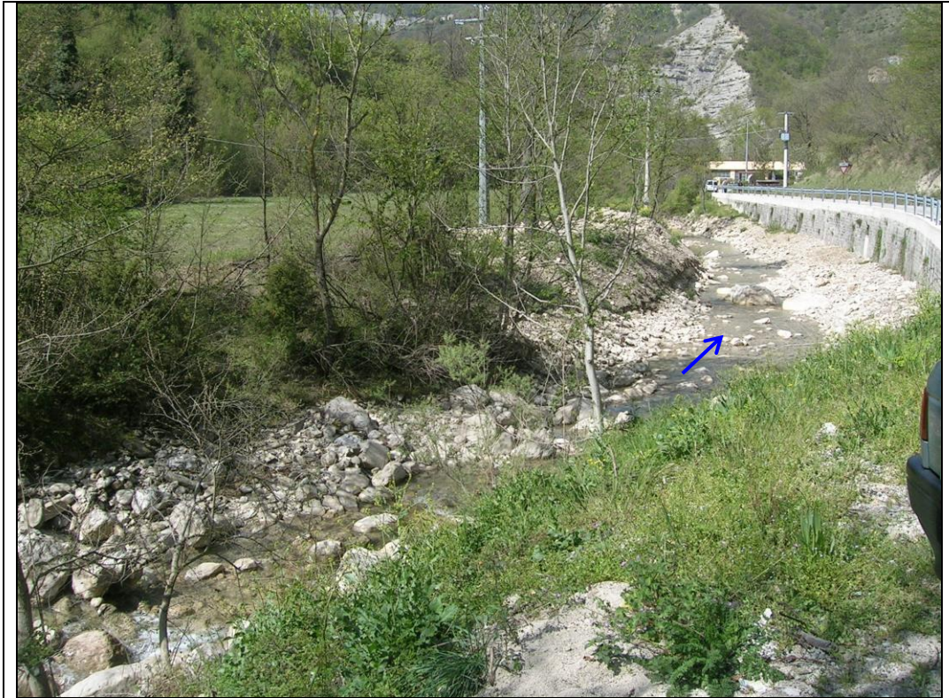
Foto 3: Zona attraversamento torrente Torbello – vista da destra idrografica
