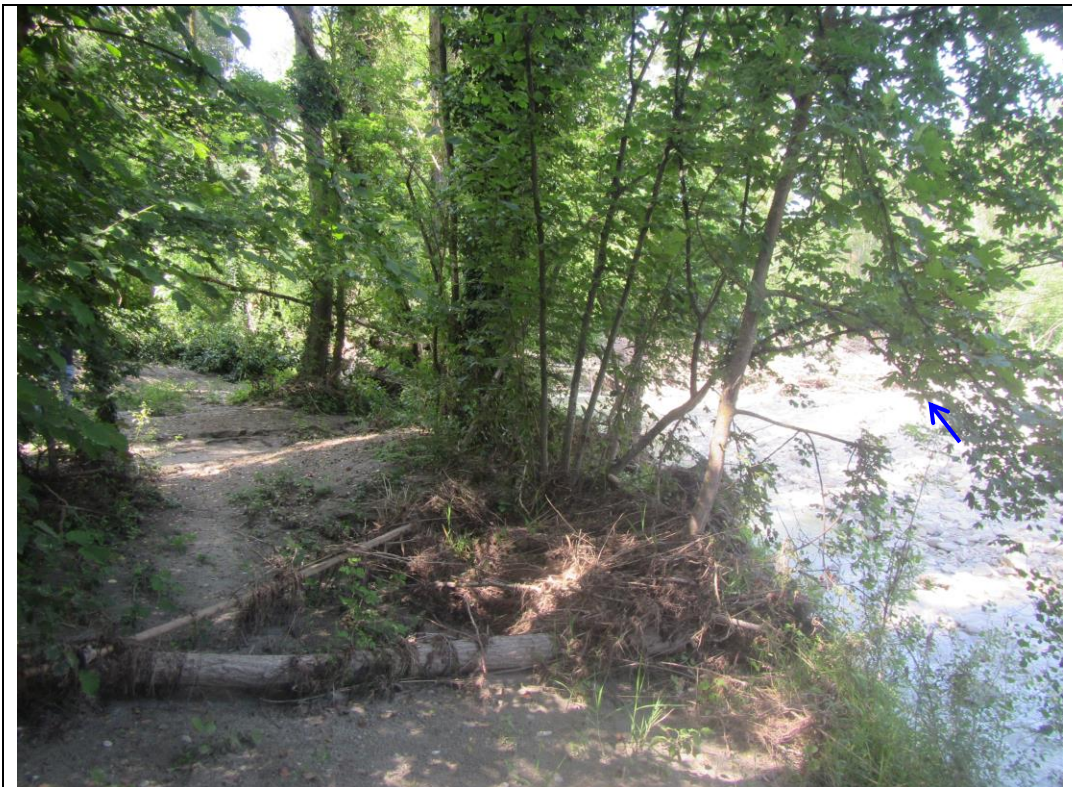
Foto: Zona 4° ambito di perc. del Fanante- vista in direzione senso gas (verso valle)
