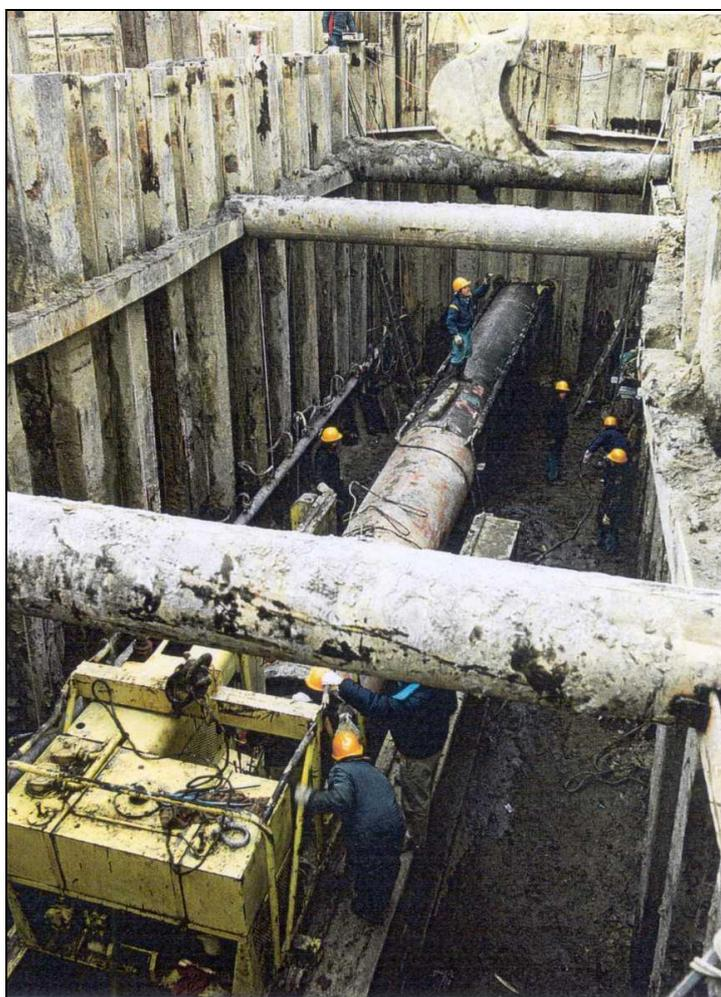
*Fig.7.2/A: Trivellazione con spingitubo*
