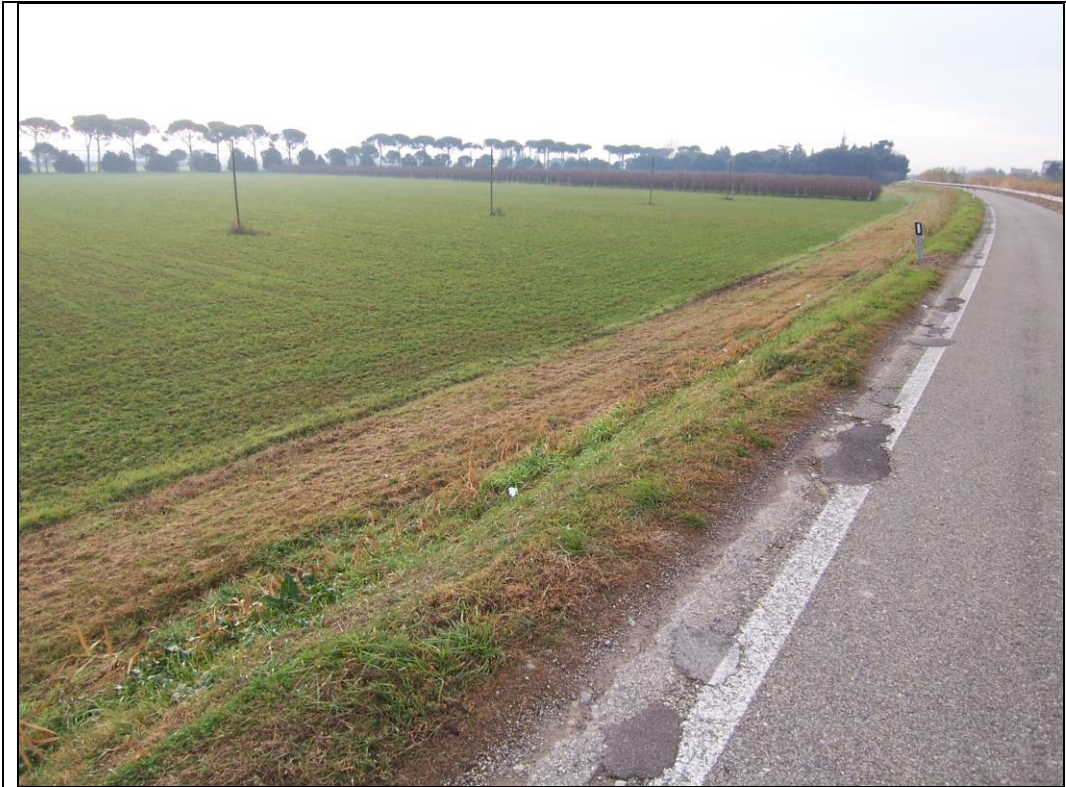
Foto 1: Ronco- lato in destra idrografica (uscita microtunnel)
