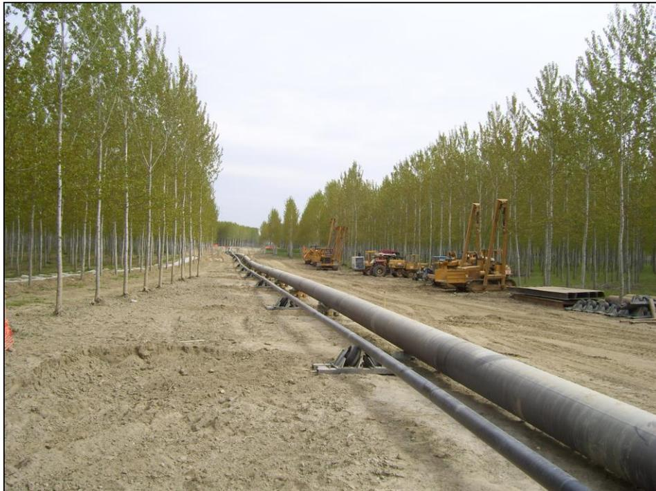
*Fig.7.4/D: Attrav. F. Po con met. 30” – Colonna di varo preassemblata lungo l'area di passaggio*
