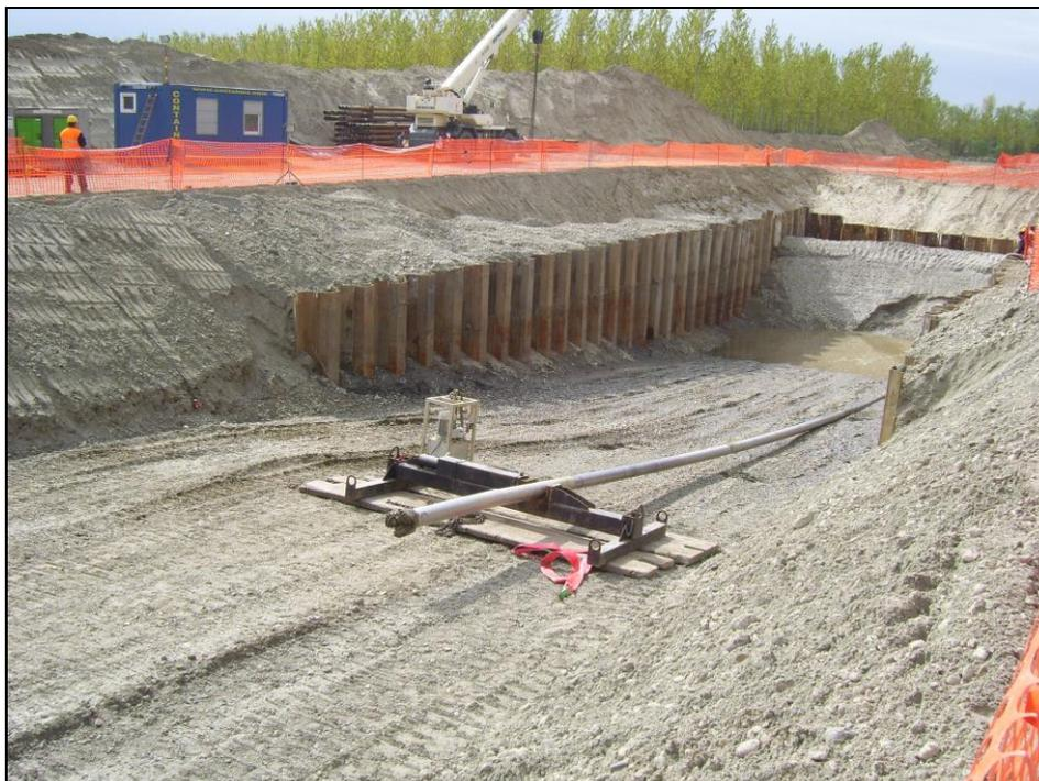
*Fig.7.4/C: Attraversamento F. Po con Met. DN30” – fase di uscita dell’asta pilota*
