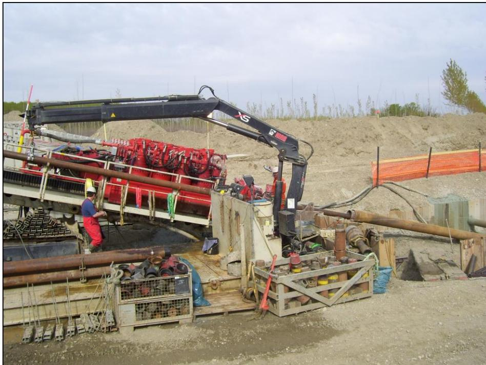
Fig.7.4/B: Attravers. F. Po con Met. DN30” – “Rig”, durante la realizzazione del foro pilota
