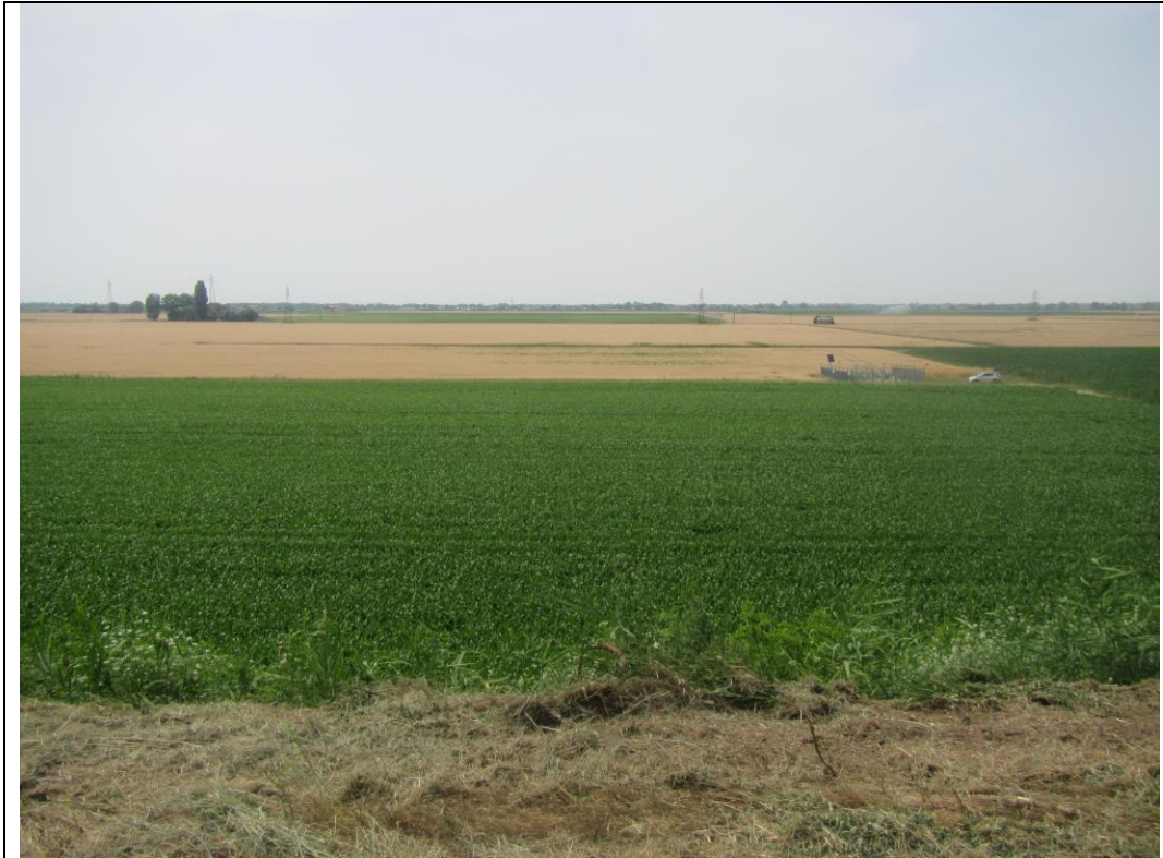
Foto 1: Sillaro - lato in sinistra idrografica (uscita della Direct pipe)
