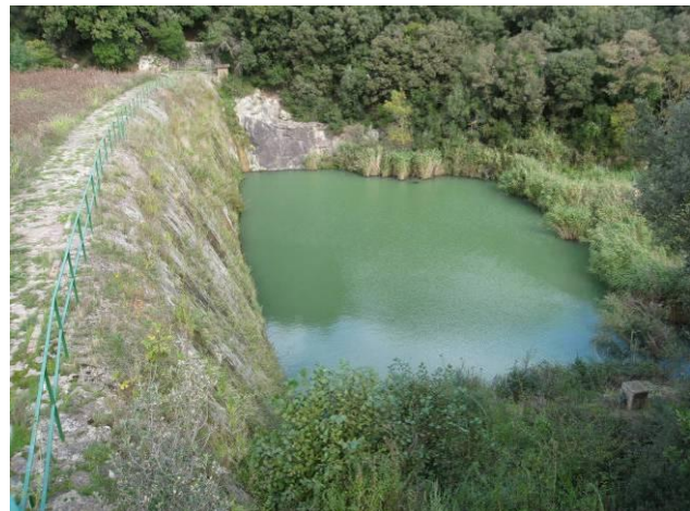
Figura 7: Diga di Vulci: Vista a valle
