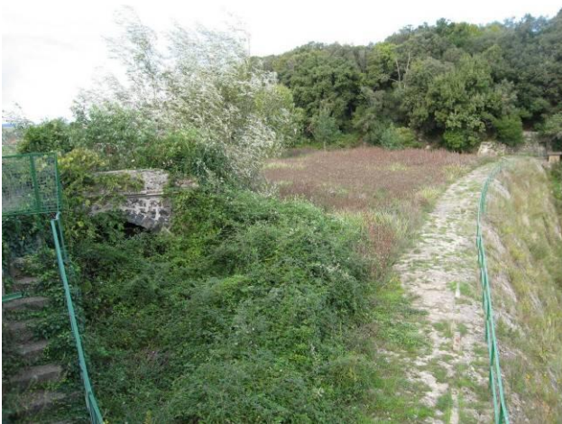
Figura 6: Diga di Vulci: Vista a monte
