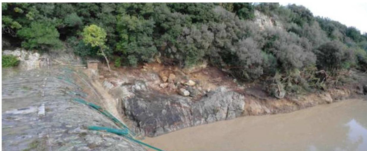
**Figura 4.4.10 – Segni dell’erosione generata dall’acqua lungo le sponde in concomitanza dell’evento alluvionale del novembre 2012**
