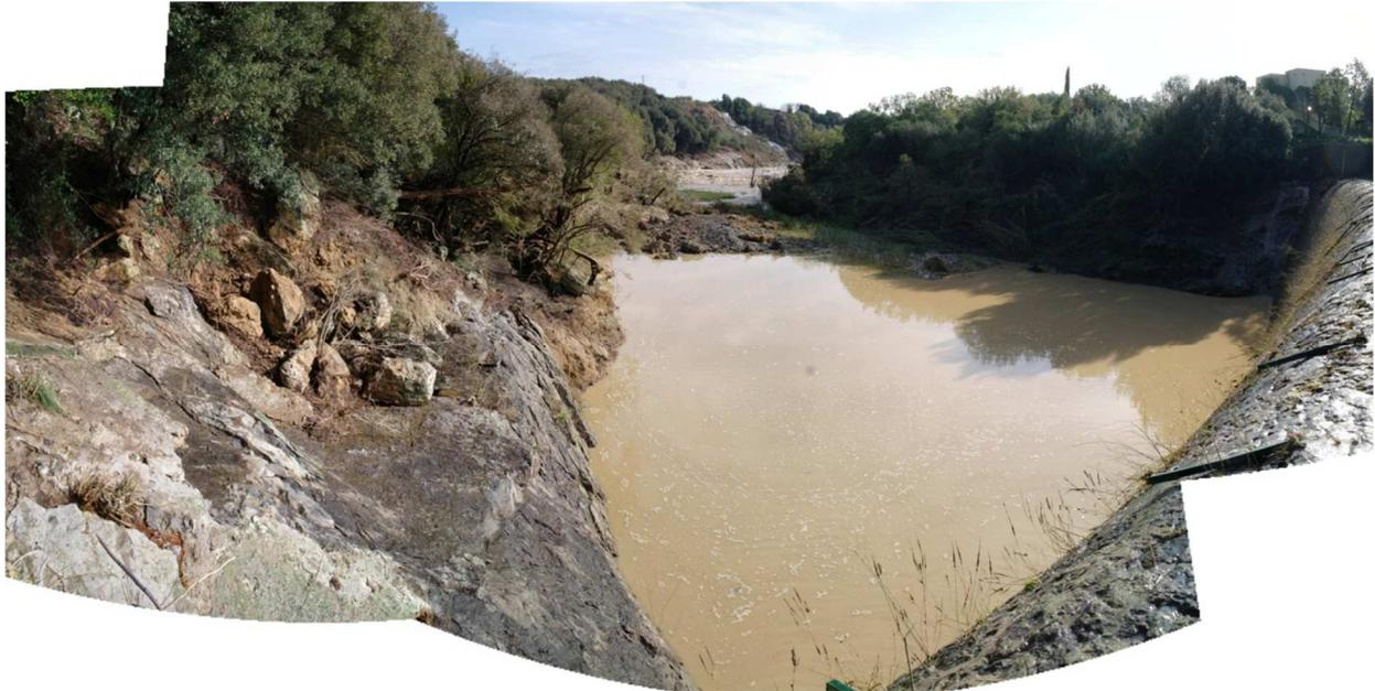
Figura 4.4.14 – Locali fenomeni di dissesto e di erosione generata dall'acqua lungo le sponde in concomitanza dell'evento alluvionale del novembre 2012
