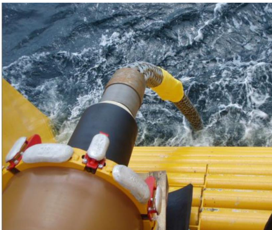
Figura 29 - Operazioni di installazione del cavo dinamico
