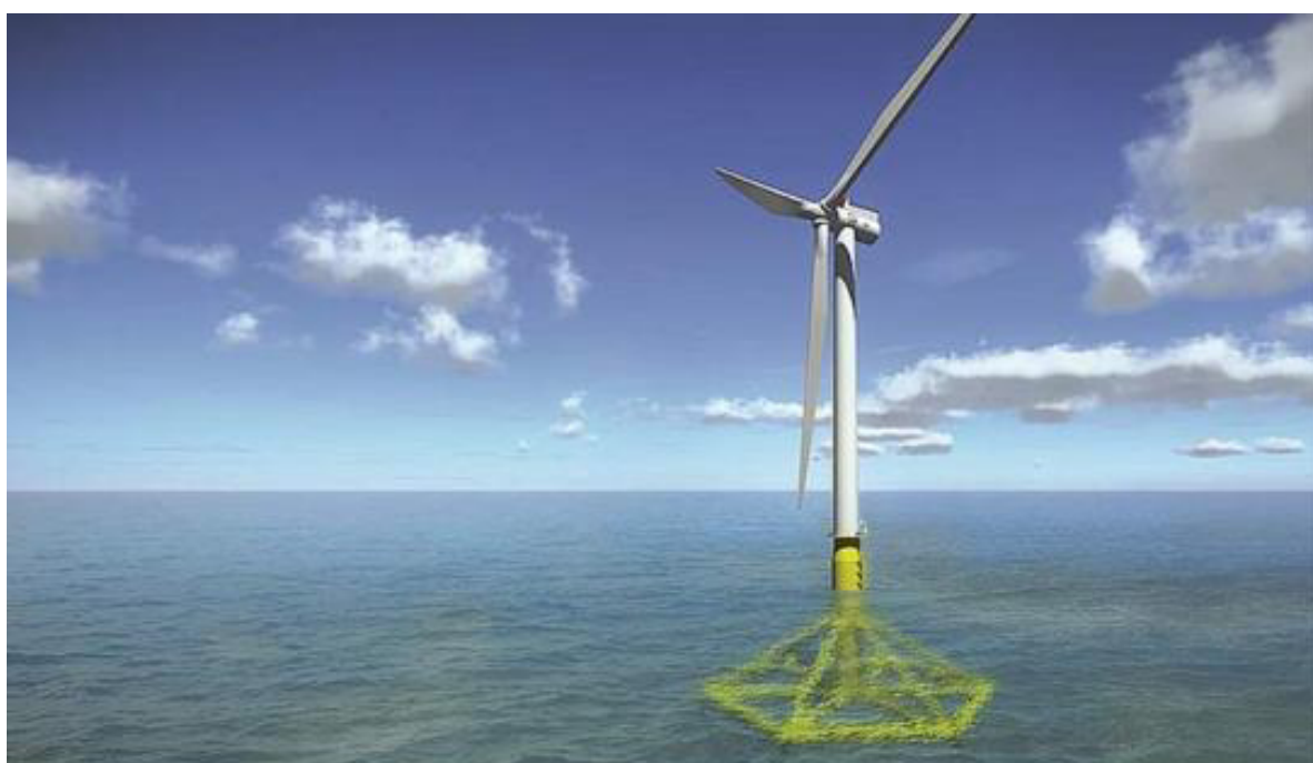
Figura 8 - Particolare della fondazione galleggiante di tipo floating
