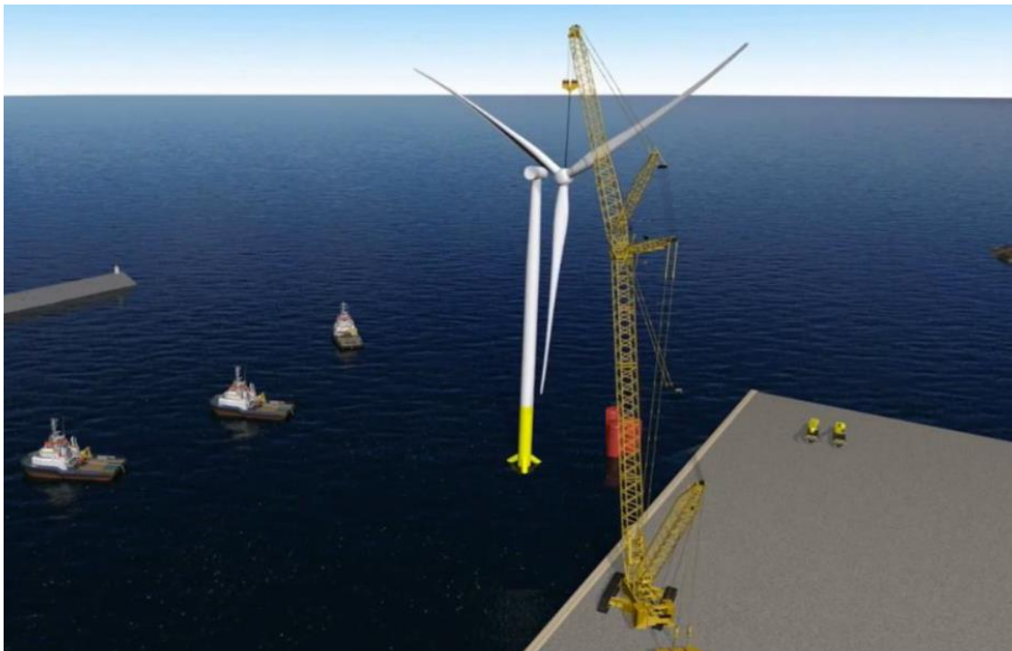
Figura 27 - Operazione di sollevamento del rotore della turbina
