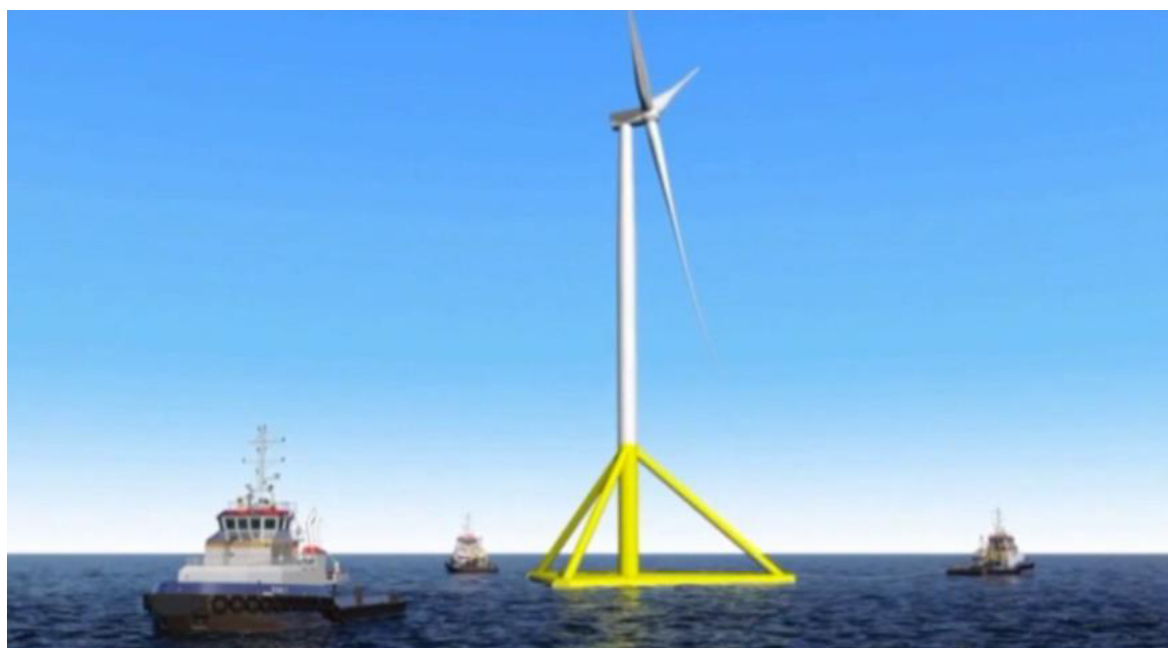
Figura 28 - Operazioni di rimorchio della turbina su piattaforma galleggiante
