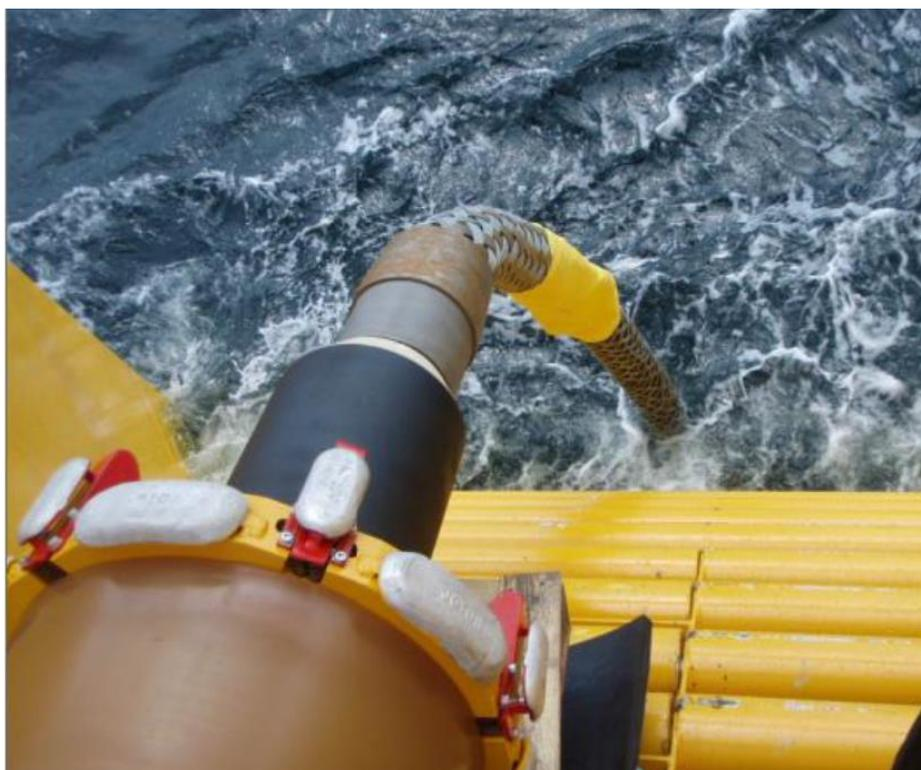
*Figura 29 - Operazioni di installazione del cavo dinamico*
