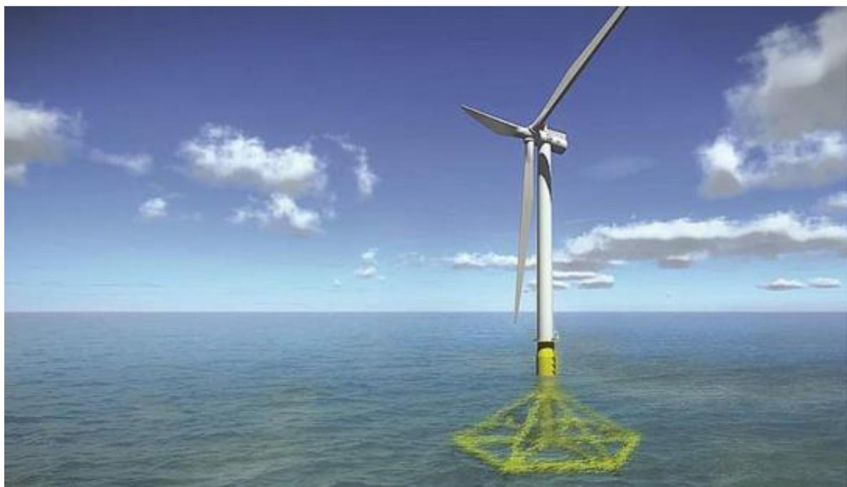
*Figura 8 - Particolare della fondazione galleggiante di tipo floating*
