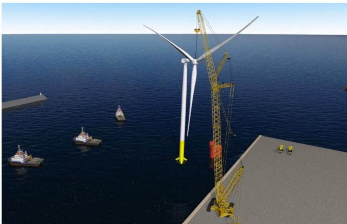
*Figura 27 - Operazione di sollevamento del rotore della turbina*
