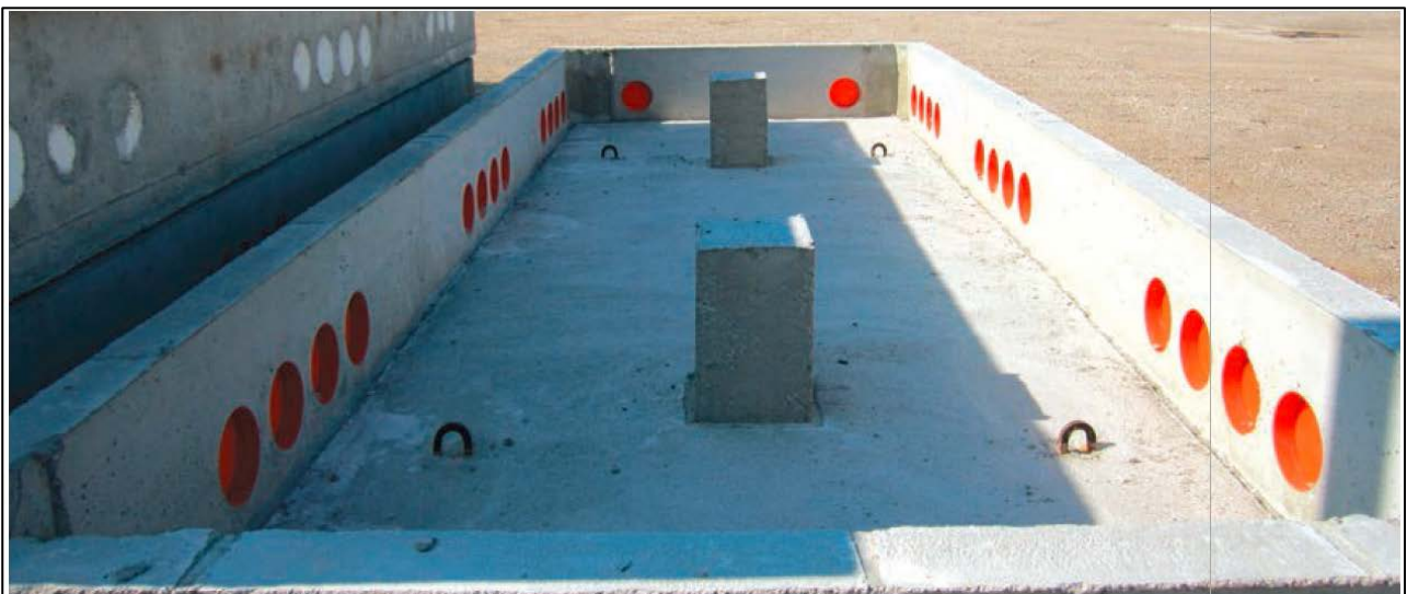
Figura 4 Vasca di fondazione in CAV
