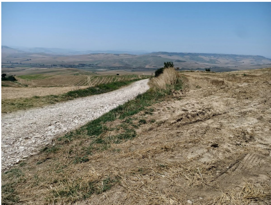
Figura 2-12. Area d'intervento (Pista con fondo sterrato)
