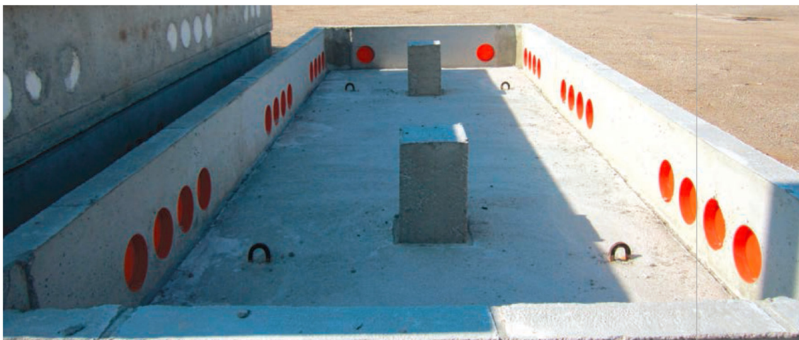
Figura 3 - Vasca di fondazione in CAV
