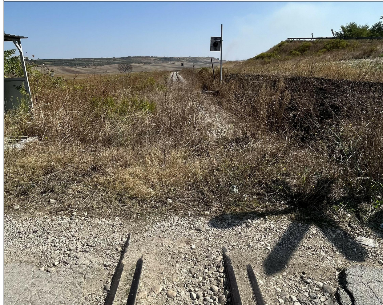
Punto di presa 3: direzione Est Interferenza con ferrovia – attraversamento con T.O.C.
