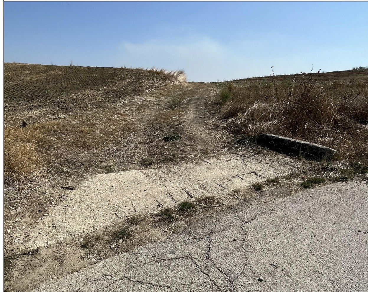
Punto di presa 4: direzione Sud Interferenza con ferrovia
