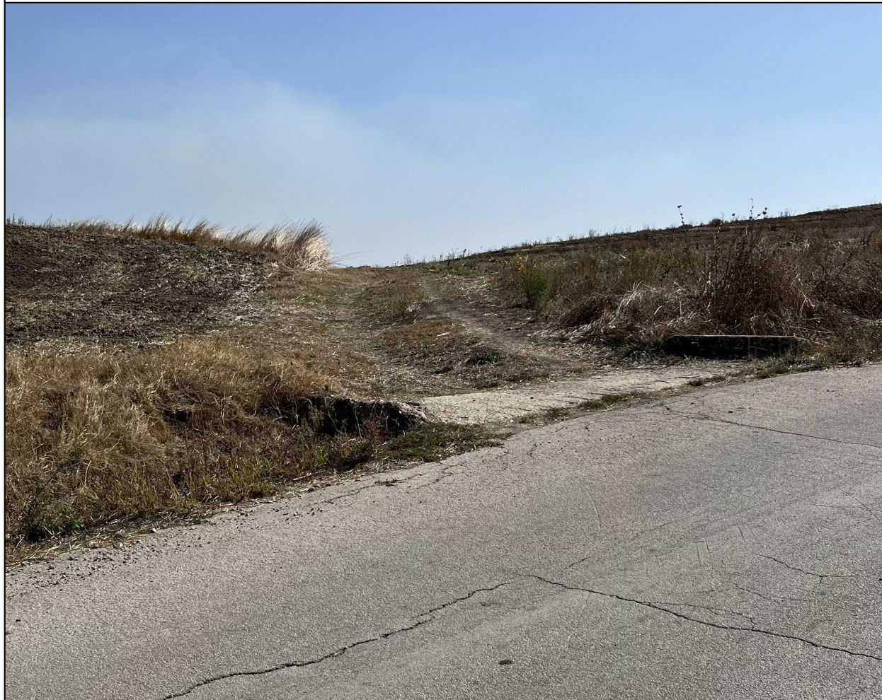
Punto di presa 3: direzione Sud Interferenza con ferrovia
