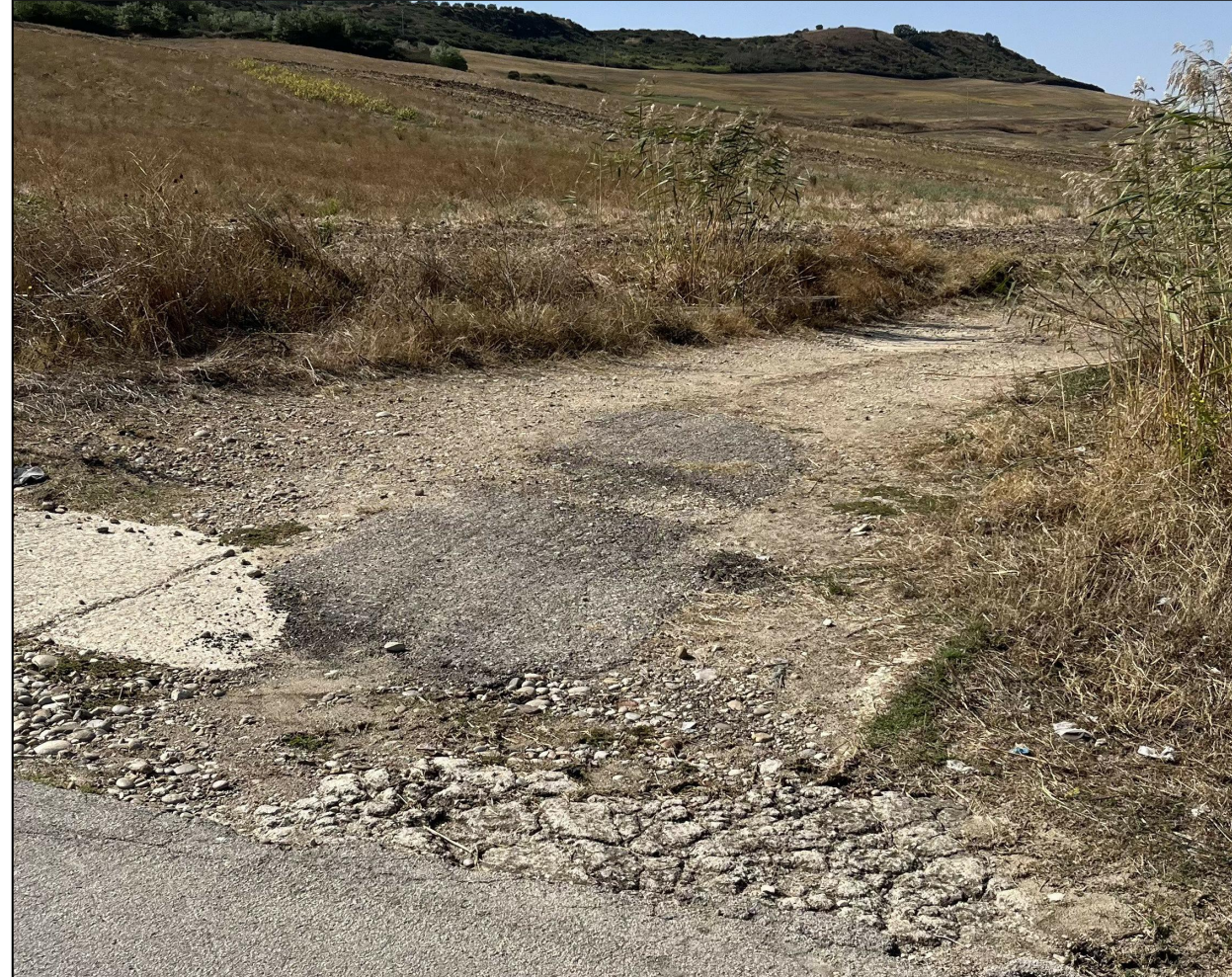
Punto di presa 2: direzione Est Interferenza con attraversamento con T.O.C.
