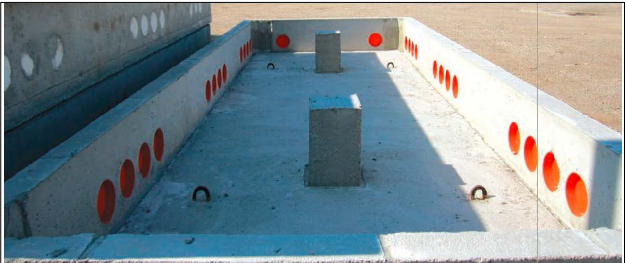
Figura 9 Vasca di fondazione in CAV
