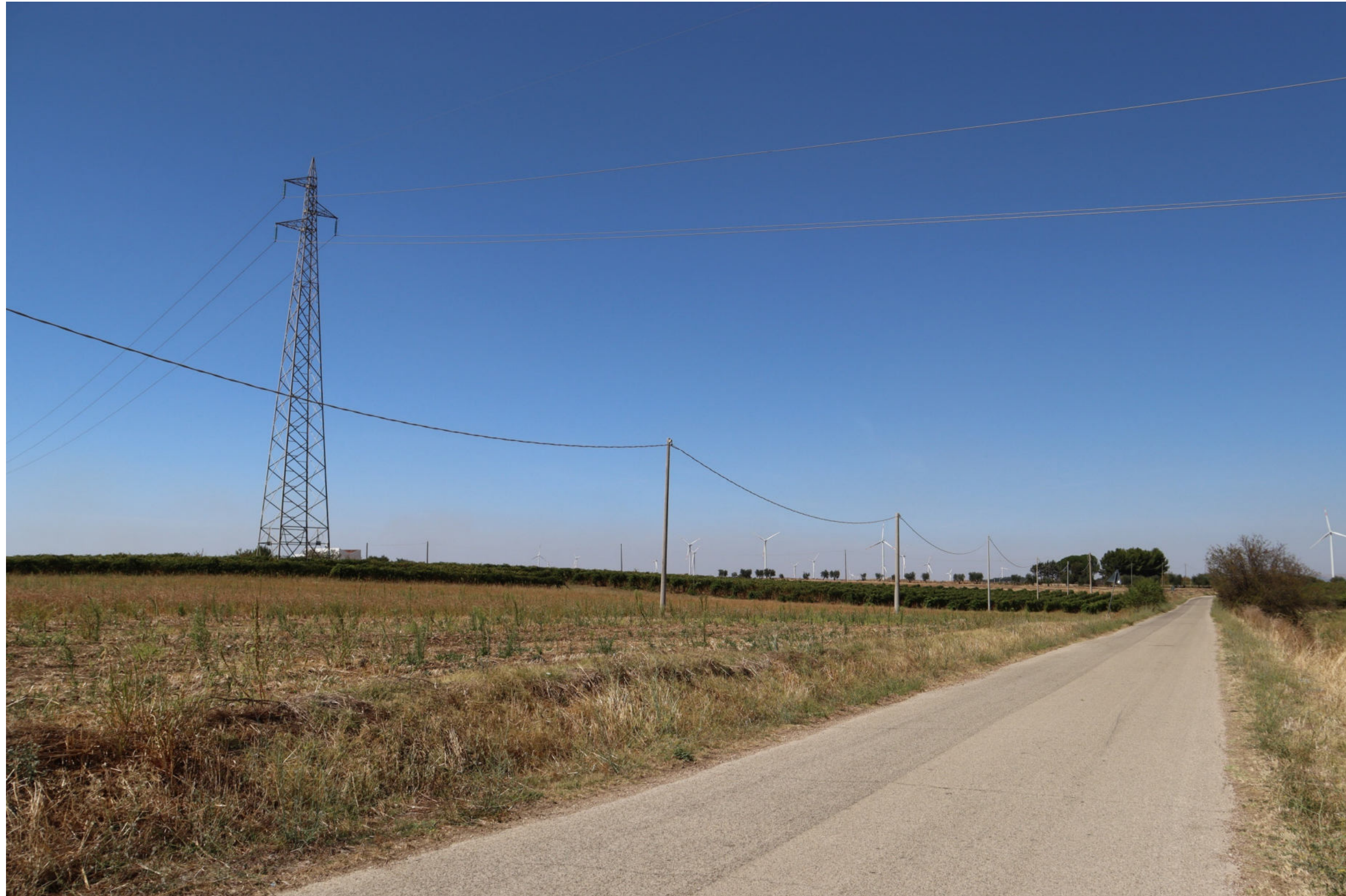
Figura 21 Stato di fatto
