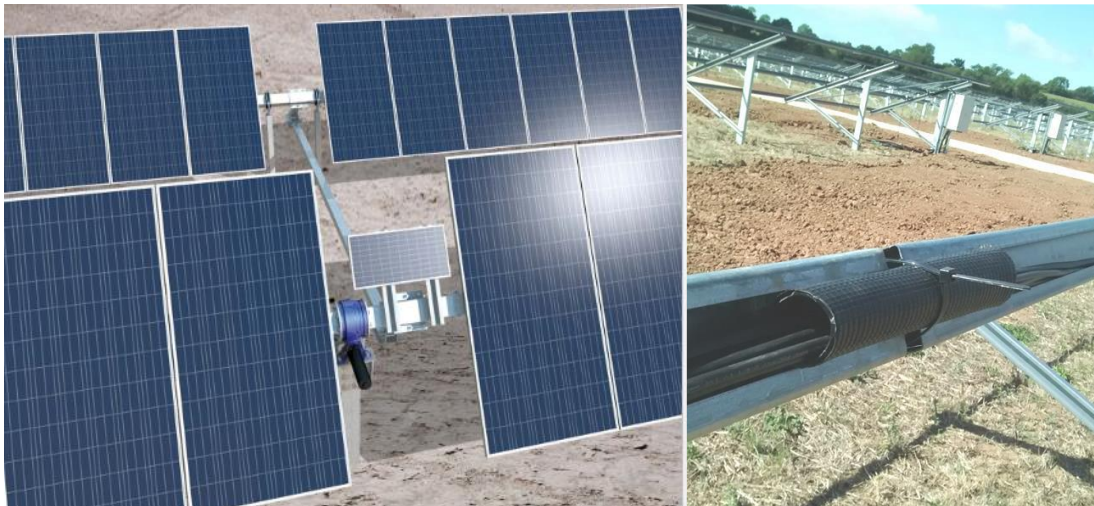
Figura 5 - Cablaggio stringhe.
