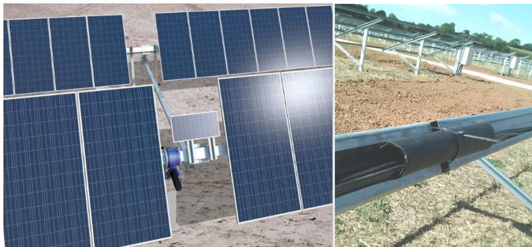
Figura 6: Cablaggio stringhe.
