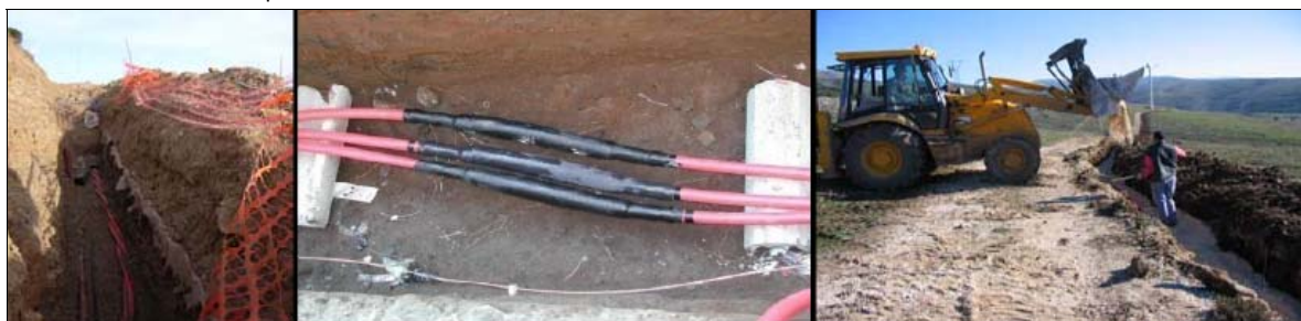
Figura 6: Esempio di scavo con posa cavi
